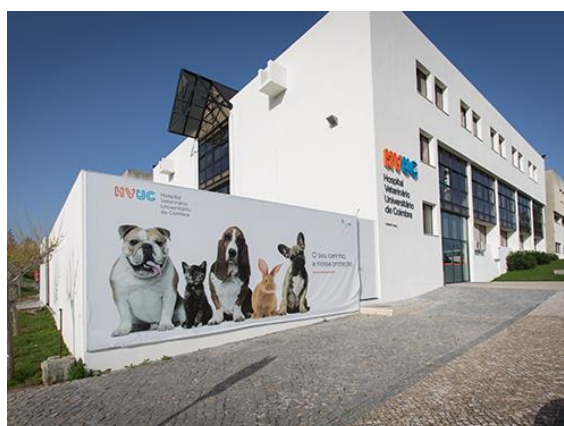
Figura 5 - Fachada Hospital Veterinário Universitário de Coimbra Fonte: Onevet Group, 2016
