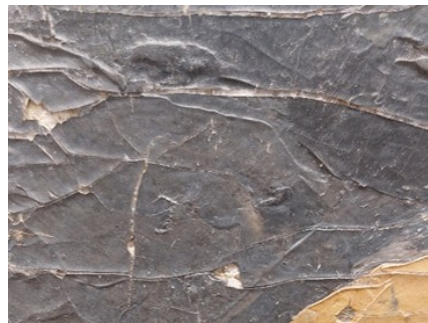
Figura 40. Zona de estalados na obra Composição .
