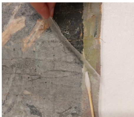
Figura 92. Remoção do facing .
