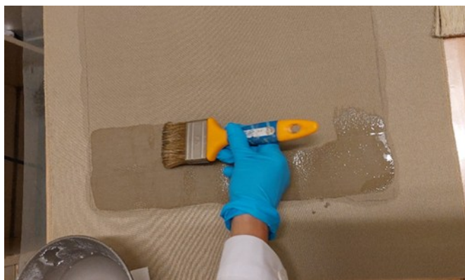
Figura 91. Preparação da tela de reforço com adesivo.
