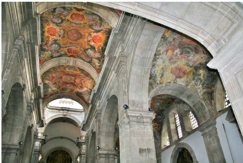
Fig. 4 – Sé de Lamego. Aspecto final após a intervenção © Joaquim I. Caetano.
