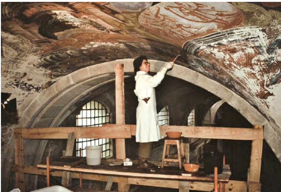
Fig. 1 – Sé de Lamego. Limpeza das pinturas com aplicação de compressas húmidas © Joaquim I. Caetano.
