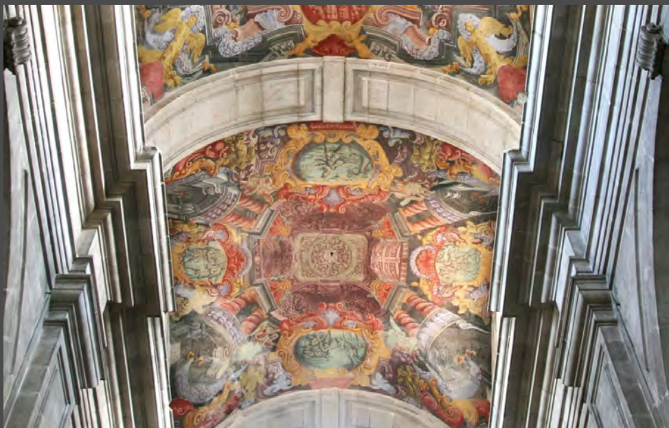
Fig. 3 – Sé de Lamego. Vista do primeiro tramo da nave central © LABFOTO–Lamego.
