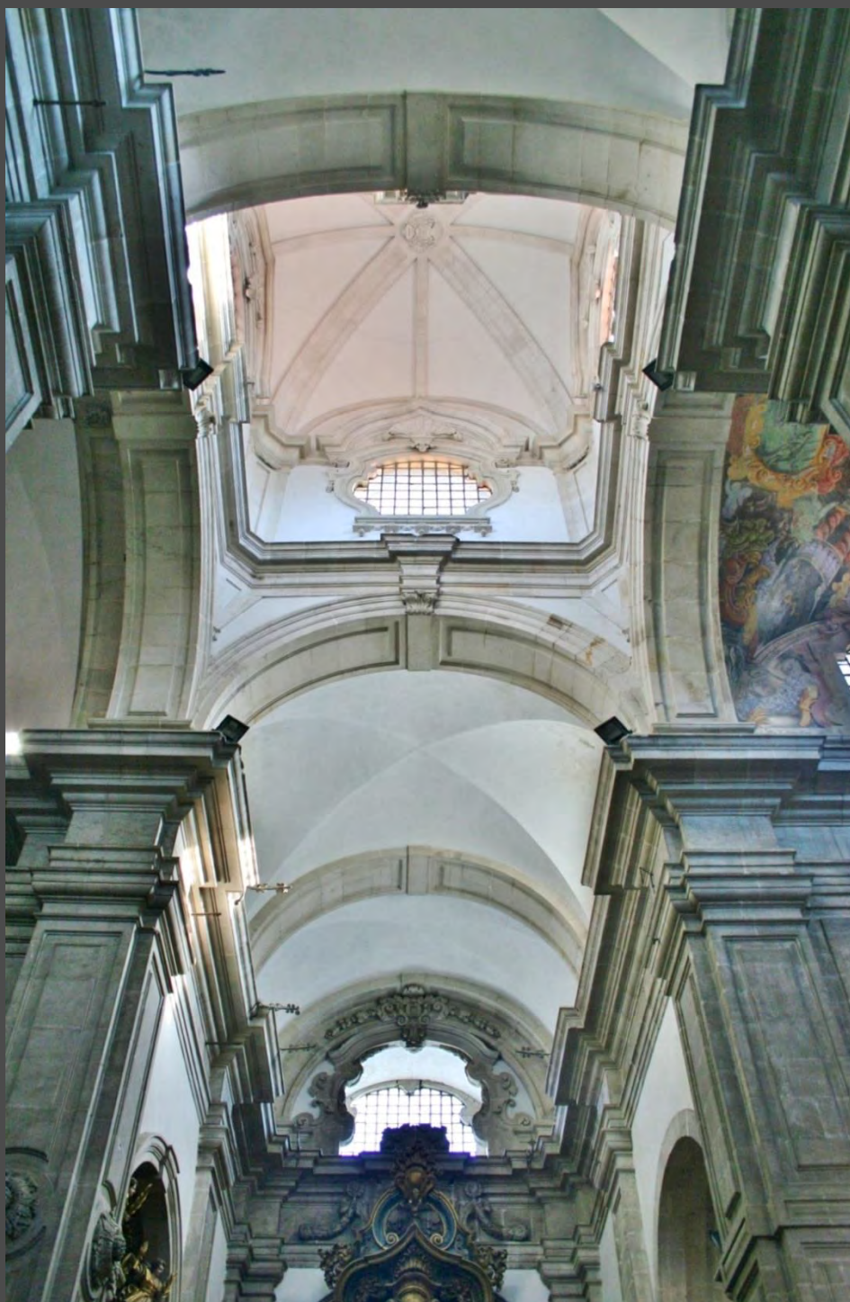
Fig. 2 – Sé de Lamego. Pormenor das janelas e das grades do cruzeiro , 1707-1709 © LABFOTO–Lamego.
