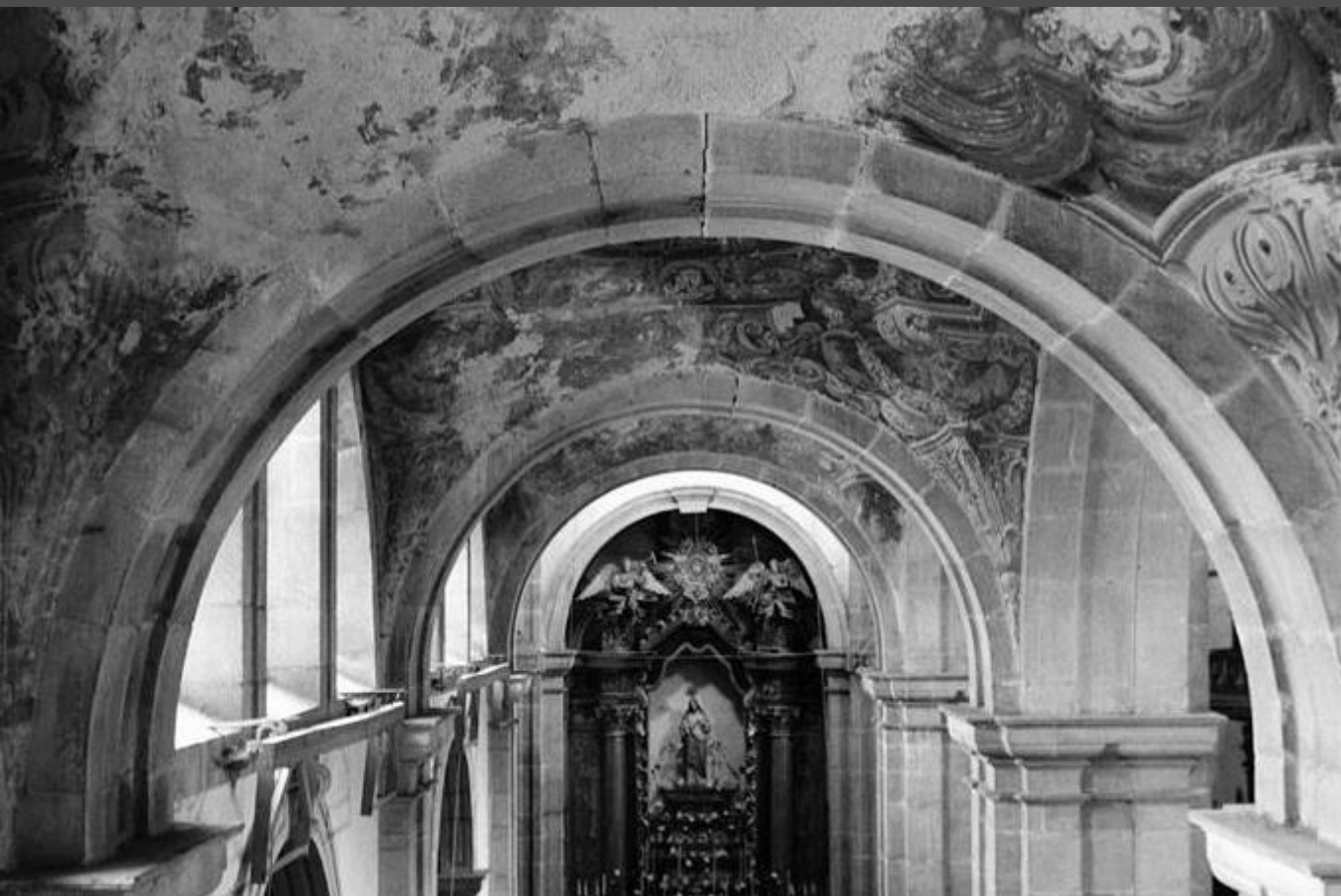
Vista superior da nave lateral Evangelho. Sé de Lamego. Alberto da Silva Bessa, 1961 © IHRU/SIPA
