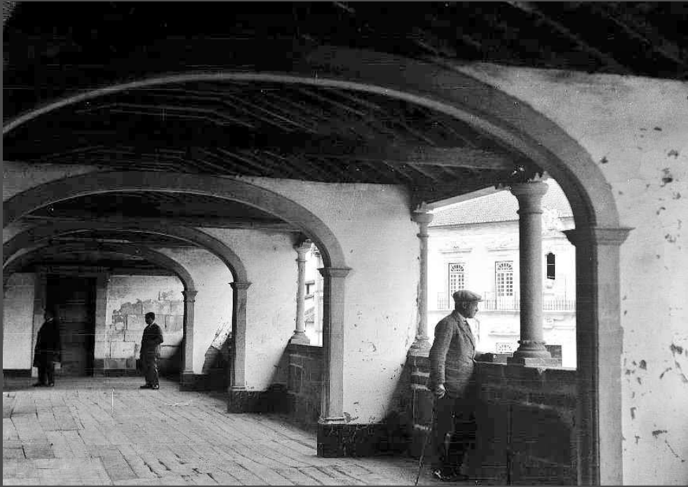
Fig. 1 – Sé de Lamego. Galeria superior (sul) antes das obras de restauro © IHRU/SIPA.
