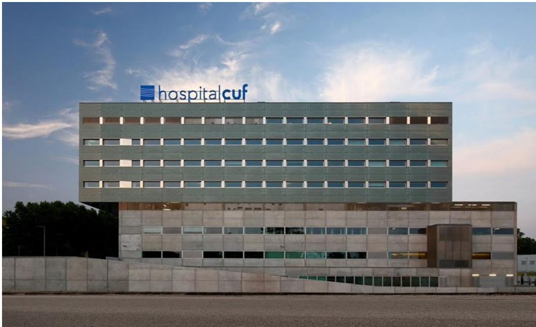
Figura 2: Aspeto exterior do Hospital CUF Porto
