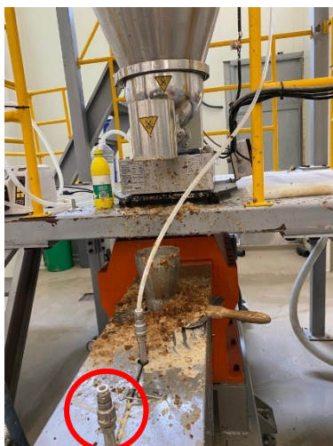
Figura 28- Entupimento do tubo de admissão de óleo
