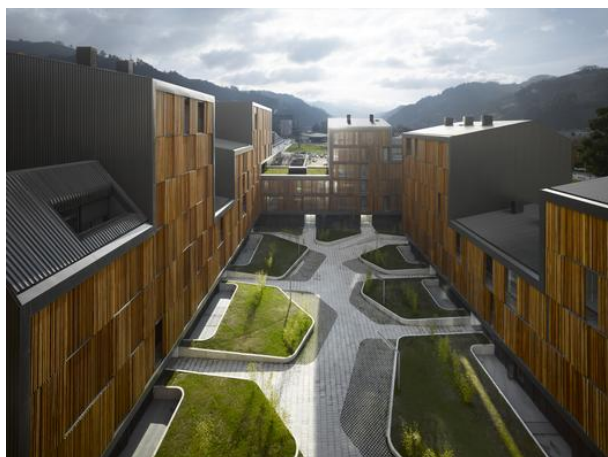
Fig.9 – Foto da fachada e espaço exterior
