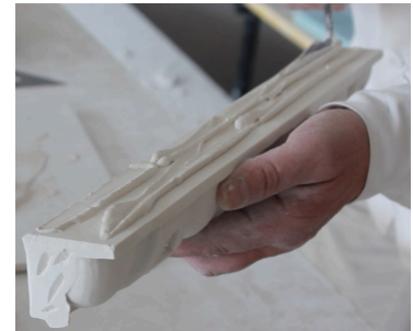
Figura 26: Aplicação do gesso cola 238 .
