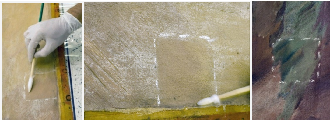
Fig.107 a 109: Teste para limpeza, remoção de verniz e condensação com resultado satisfatório.
