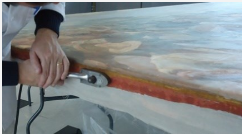
Fig. 141 a 144: Revisão geral do reforço de borda com espátula térmica
