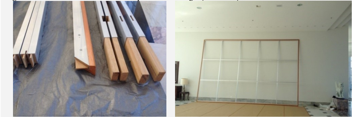
Fig. 135 e 136: Chassi definitivo no Salão de inverno, desmontado e montado
