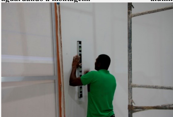
Fig. 149: Marcação da parede para receber a obra.
