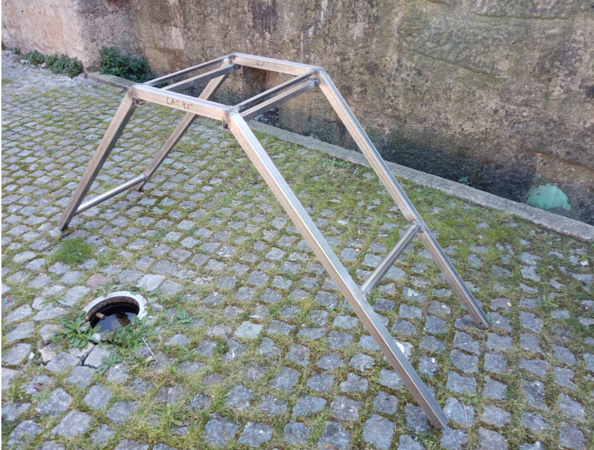
Figura 15 - Montagem da estrutura.
