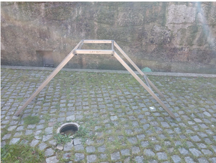
Figura 16 - Montagem da estrutura.
