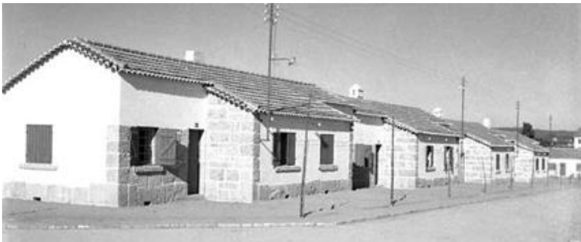
Figura 21 – Fogos de tipologia T3 no Bairro Municipal em Viseu
