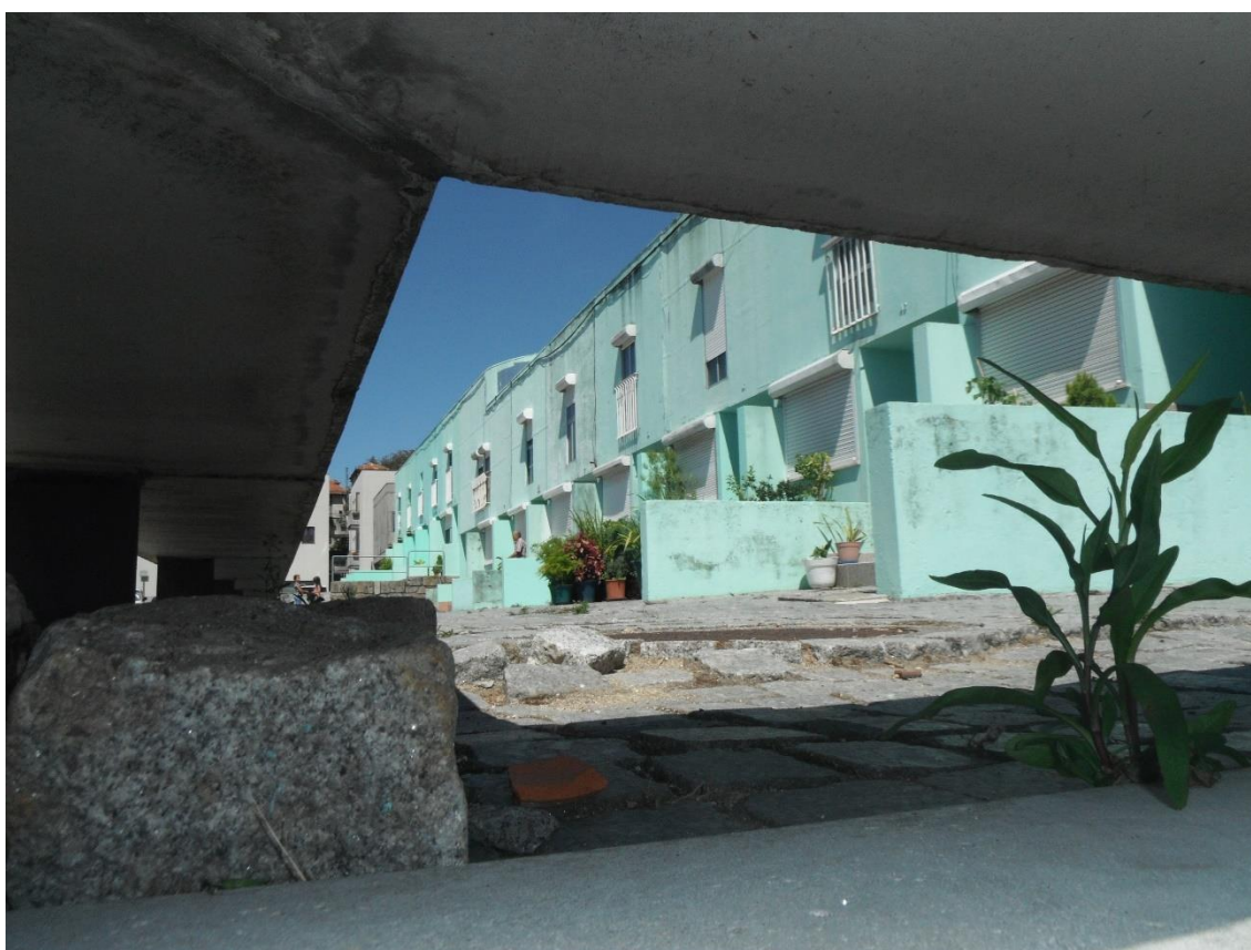
Figura 40 – Vista do conjunto habitacional de S.Victor
