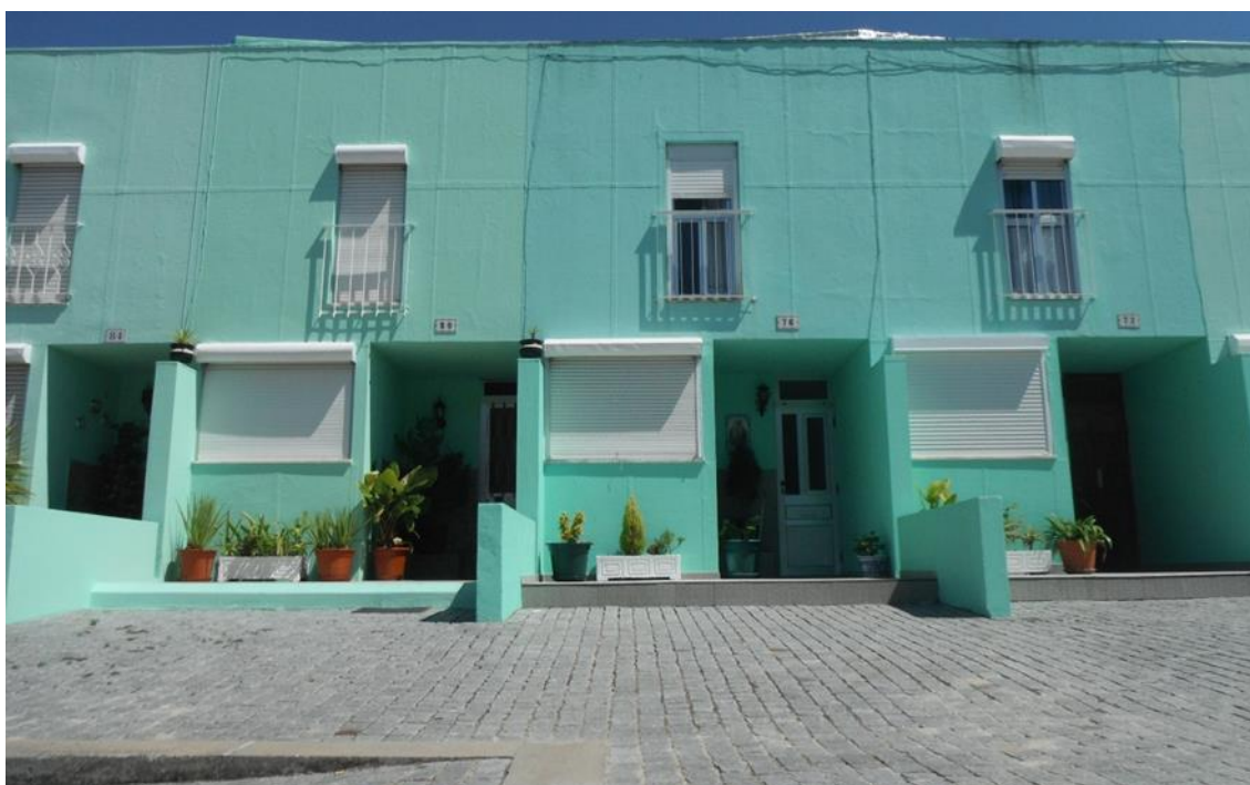
Figura 26 – Fachada principal dos fogos de S. Victor
