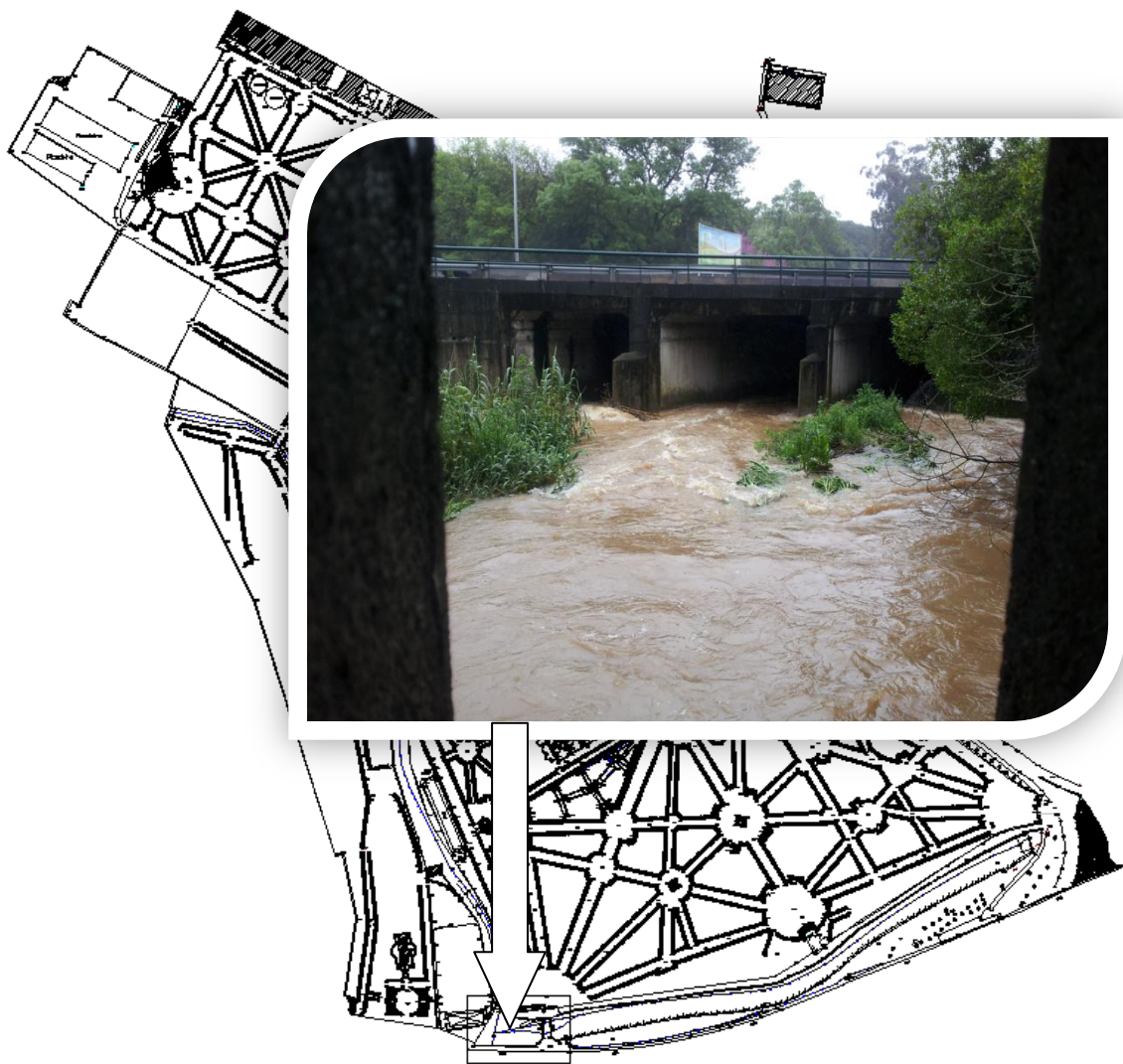
Figura 2.22 - Confluência do Rio Jamor com a Ribeira de Carenque (vista de montante) (31/03/2013)
