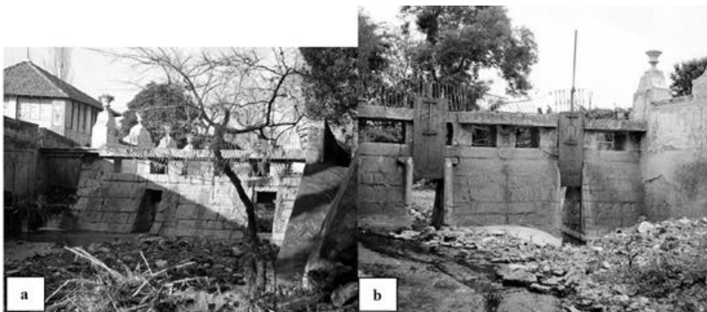
Figura 5.17 - Comportas rígidas do canal junto ao actual Pavilhão do Chá (1954), a) vista de jusante, b) vista de montante (Pereira e Luckhurst, 2005)
