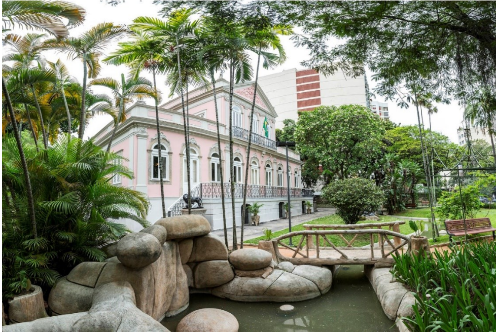
Figura 9: fachada do Museu Casa de Rui Barbosa. Fonte: fotografia de Ivo Gonzalez.
