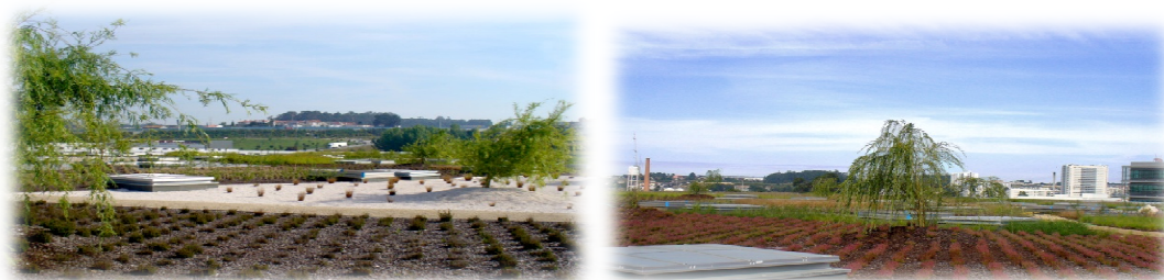
Figuras 4.8 e 4.9 – Registo fotográfico da cobertura do Centro de logística da SONAE, situado na cidade da Maia, na data da conclusão da obra em 2010. Fonte: Arquitecta Paisagista Laura Roldão Costa
