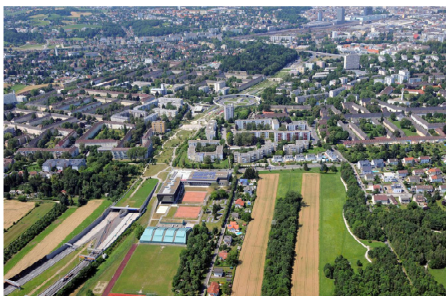
Figura 2.6– A7 motorway tunnel in Cidade de Linz, na Áustria
