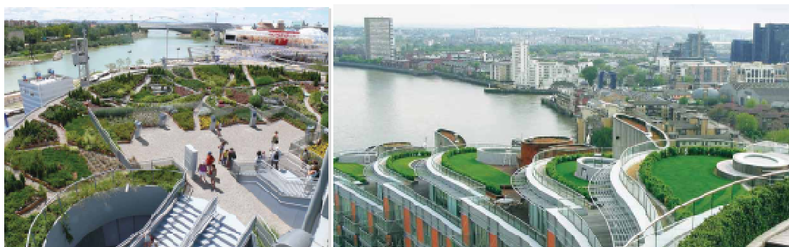
Figura 1.8 – Cobertura ecológica na Expo, Saragoça Figura 1.9 – Cobertura ecológica do edifício New Providence Wharf, Londres
