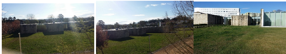
Figura 6.4 a 6.6 – Vários vistas da Escola Ambiental do CEAQG. Fonte: Divisão de Ambiente da CMM
