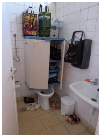
Figura 20- Inexistência de vestiário adequado, com separação clara dos sanitários
