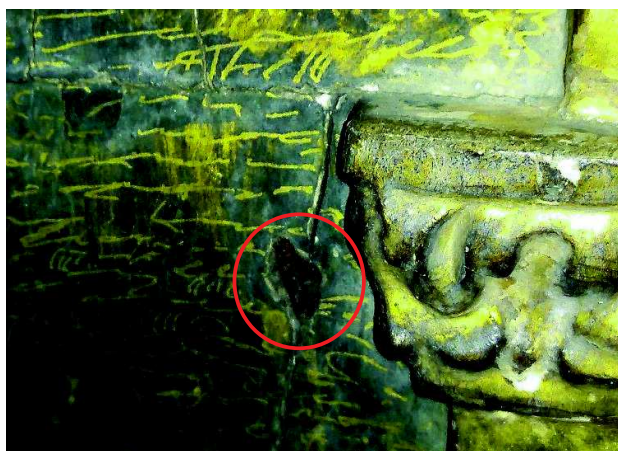
Fig. 34 – Elemento metálico localizado na segunda tábu, a meia altura.
