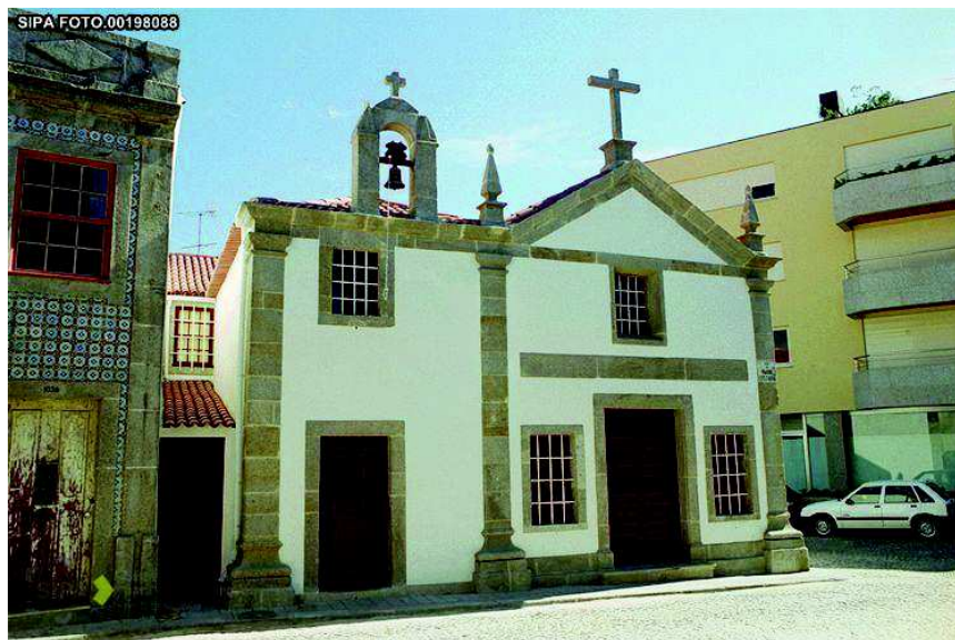
Fig. 1 - Fachada principal da Capela de Santa Anastácia, na Foz do Douro.
