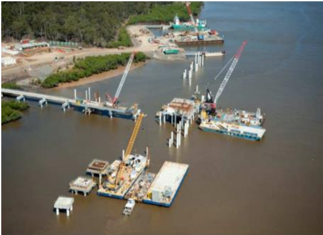
Fonte: Anadarko, Moçambique Lda –imagem de estaleiro que será montado na baía de Pemba
