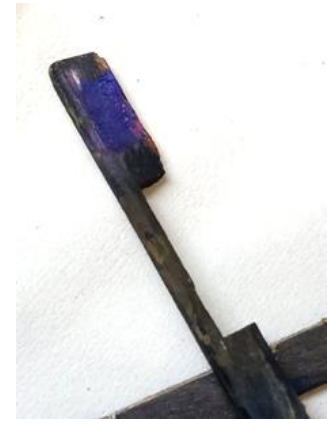
Figura 39 - Manchas de tinta nas divisórias de madeira. (Mariana Sá ©)
