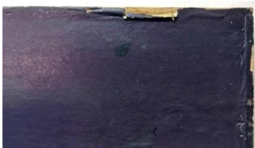
Figura 311- Destacamento de material no verso da parteleira. (Mariana Sá ©)
