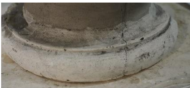
Figura 222- Resultado da primeira aplicação de PVA-B na bas. (Mariana Sá ©)
