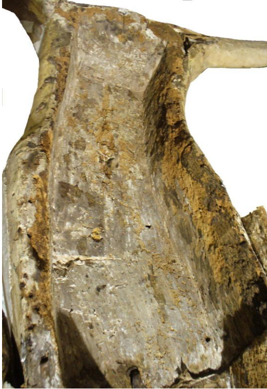
Fig. 182 – Após a limpeza mecânica da zona escavada.
