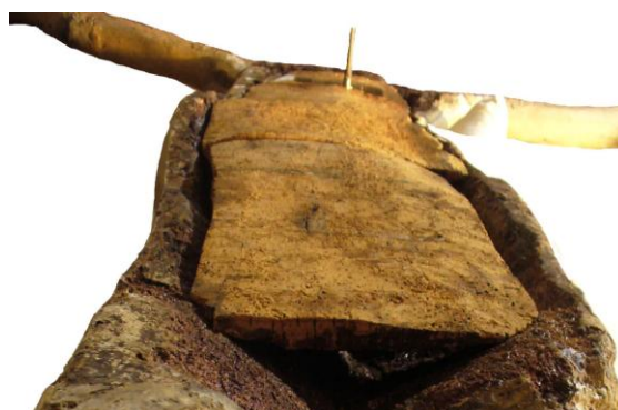
Fig. 200 – Fixação das placas de cortiça.
