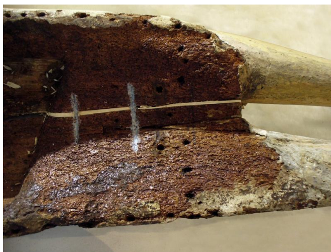
Fig. 186 - Aplicação de fibras e resina epóxida nos rasgos.
