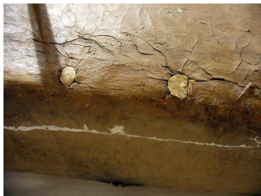
Fig. 202 - Reposição da pele. Preenchimento de furos e nivelamento.
