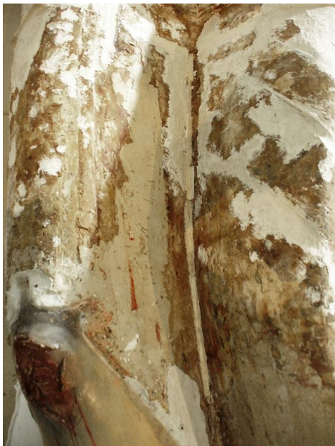
Fig. 192 – Nivelamento de suporte.
