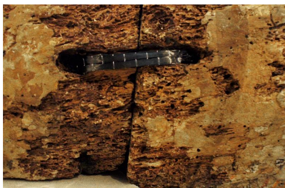
Fig. 188 - Aplicação de fibras de carbono nos rasgos laterais onde existiam os grampos metálicos.
