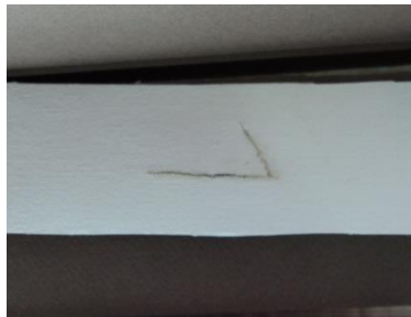
Figura 129 – AD1 Resina epóxida
