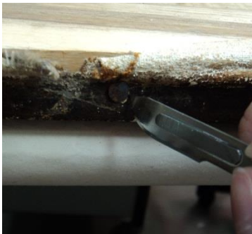
Figura 75 – Recorte da tela à volta dos elementos metálicos
