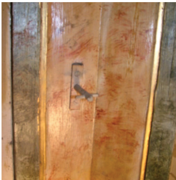
Fig 10- Ferragem existente no interior do camarim, onde provavelmente se movia o tambor.
