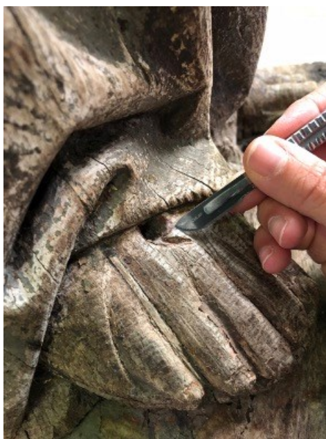
Figura 34 - Fissura intervencionada com madeira de baixa densidade.
