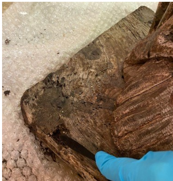
Figura 36 - Massa de preenchimento resultante de intervenção posterior.
