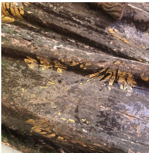
Figura 31 - Destacamento a nível da camada de douramento.
