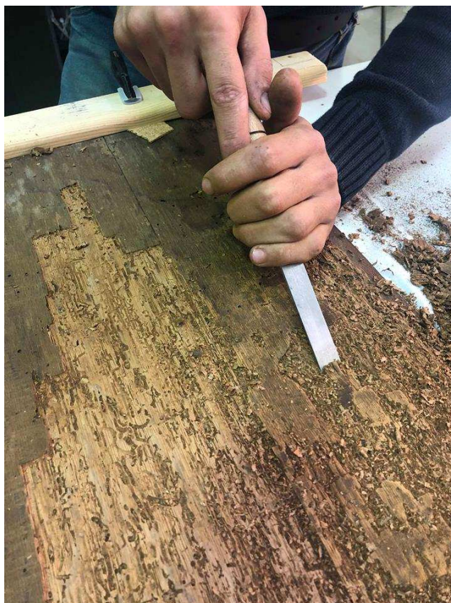
Figura 30 - Remoção da podridão cúbica a formão
