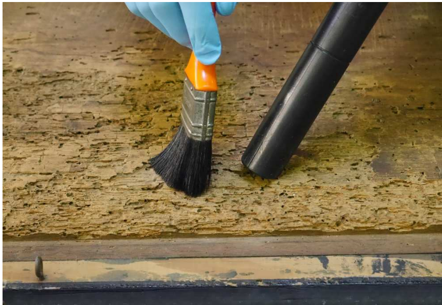
Figura 27 - Limpeza mecânica com trincha e aspirador
