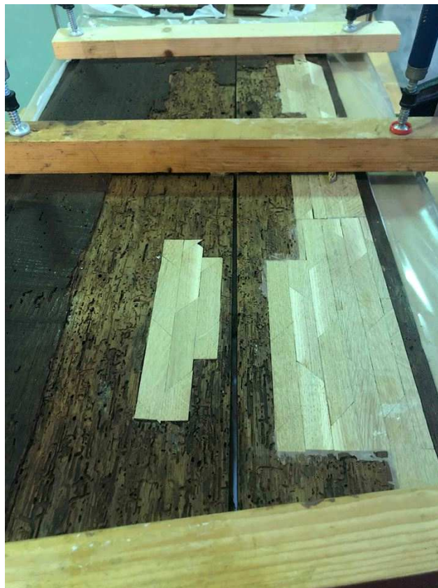
Figura 32 - Aplicação do sistema de parquetagem
