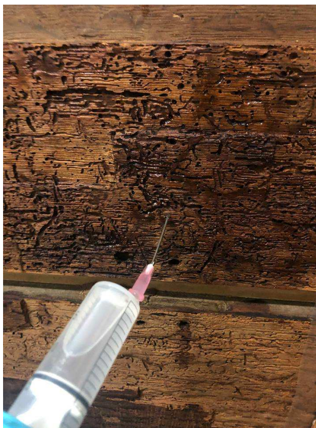
Figura 31 - Consolidação do suporte
