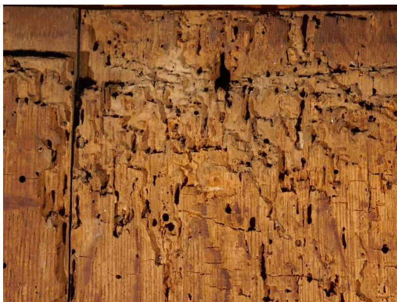
Figura 16 – Marcas de ataque de insetos xilófagos e podridão cúbica
