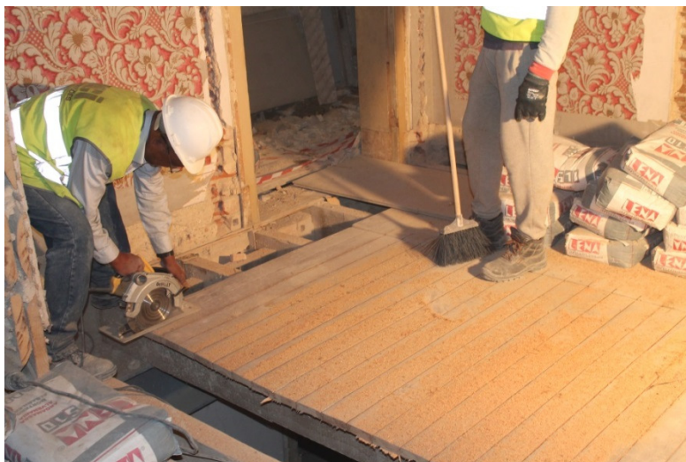
Figura 8.6 – Corte do macheado do soalho.
