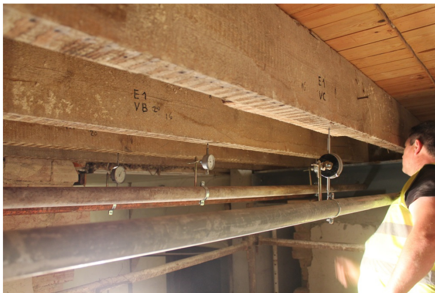
Figura 8.2 – Montagem dos defletómetros.
