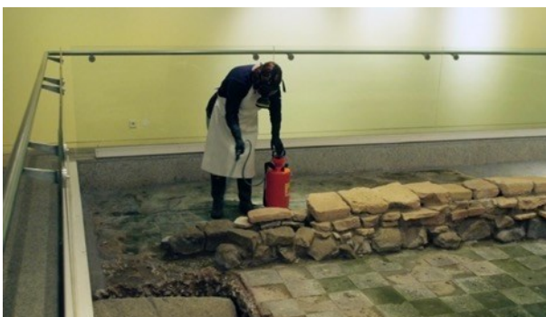
Figura 18 Aplicação de um dos biocidas da testagem realizada em 2011, no mosaico do MDDS. Créditos: Arquivo do Museu D. Diogo de Sousa © Braga.
