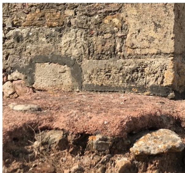
Figura 39 Vista de pormenor das “marcações pretas” como elementos separadores entre os materiais adicionados e o original, dos restauros de D. Fernando d’Almeida sobre as Ruínas de Miróbriga. Créditos: Mariana N. Durana Pinto © 2022.
