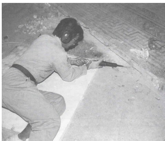
Figura 1 Remoção da argamassa cimentícia de reassentamento de um dos mosaicos de Torre de Palma, no MNA, por meios mecânicos. Arquivo pessoal de Vítor Hugo Torres ©.
