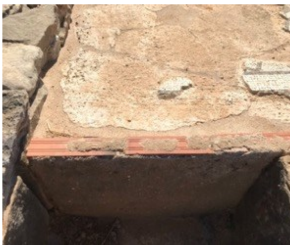
Figura 45 Vista de pormenor de um restauro com recurso a cimento e tijolos contemporâneos das Ruínas de Milreu (possível de ser de 1994 ou anterior), em julho de 2022. Créditos: Mariana N. Durana Pinto © 2022.
