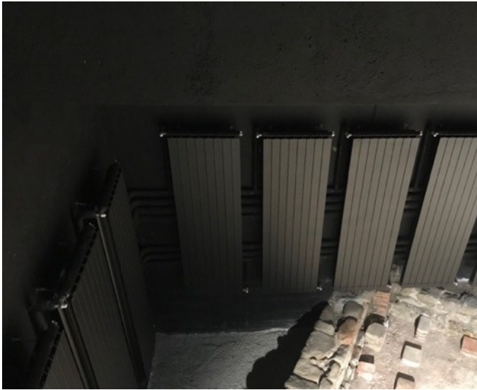
Figura 5 Vista de pormenor dos radiadores responsáveis pelo controlo de temperatura da água e do ambiente atmosférico do Espaço-Museu das Termas Romanas de Chaves. Créditos: Mariana N. Durana Pinto © 2022.
