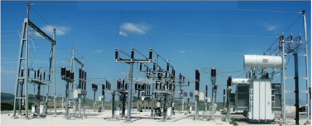
Figura 2b – Parque Exterior das Aparelhagens
