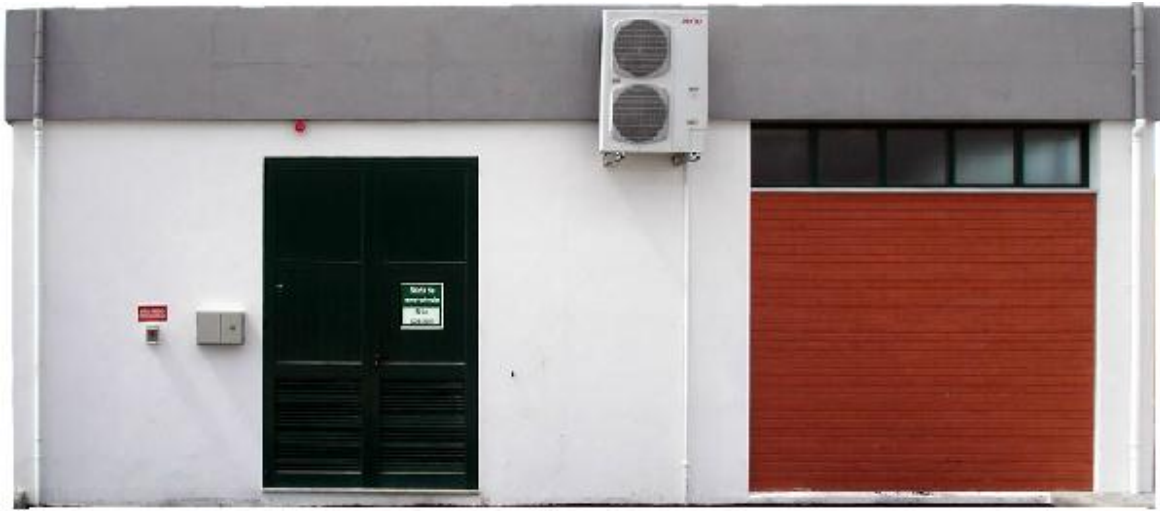
Figura 2a – Edifício de Comando (parte exterior)
