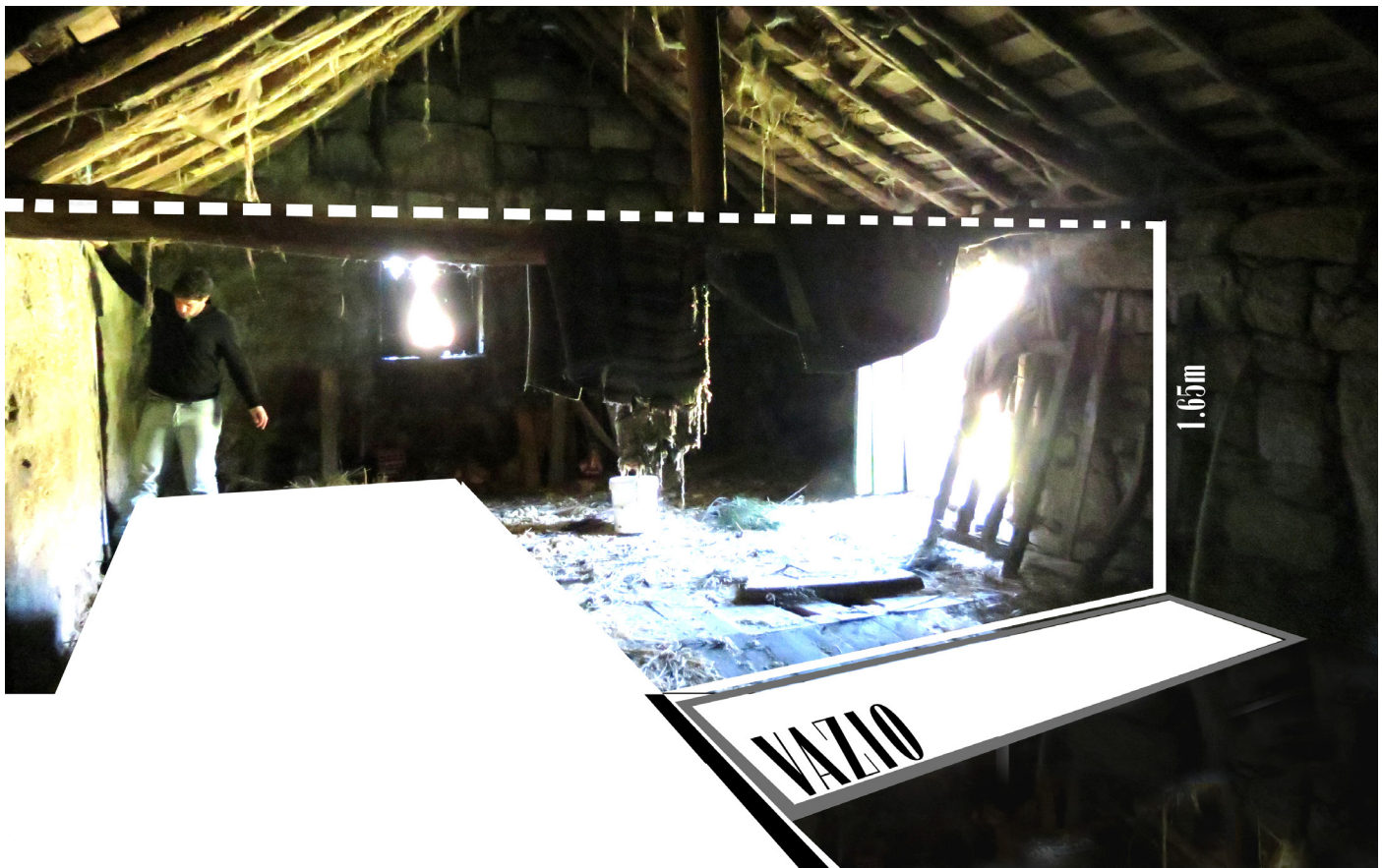
Fig.47: Fotomontagem-explicação abertura de pavimento (Fonte: do autor)
