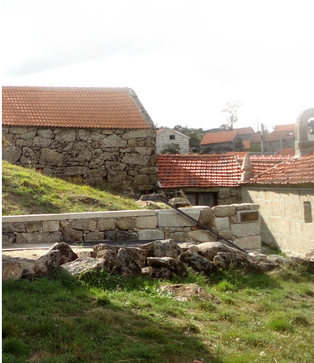
Fig.66: Vista geral alçado Nascente e escada (Fonte: João Almeida)
