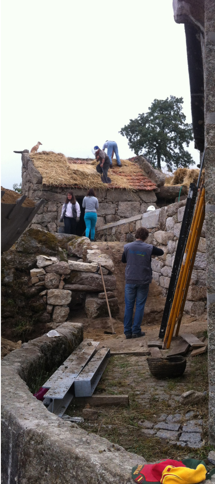
Fig. 77: Chegada da escada da Arestalfer (Fonte: Cláudia Rodrigues)
