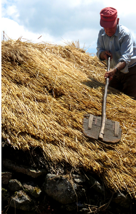
Fig.14: Colmagem do Sr. Manuel-várias etapas
