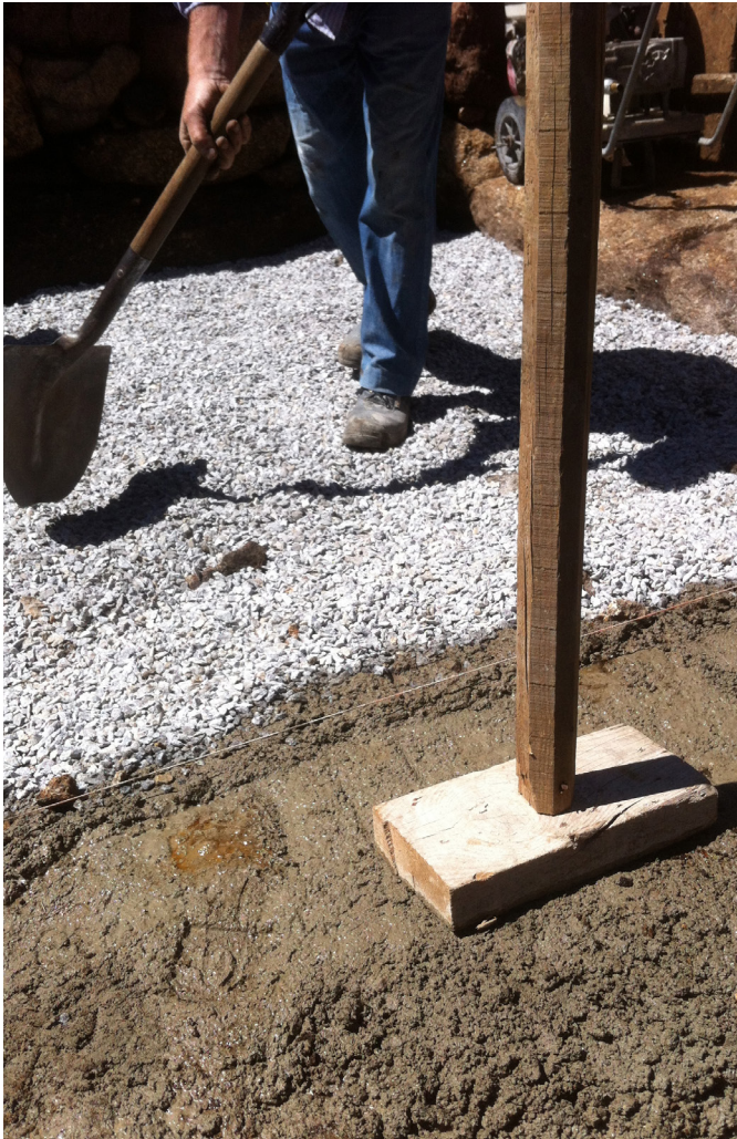
nivelamento de argamassa - retirar águas e impurezas
