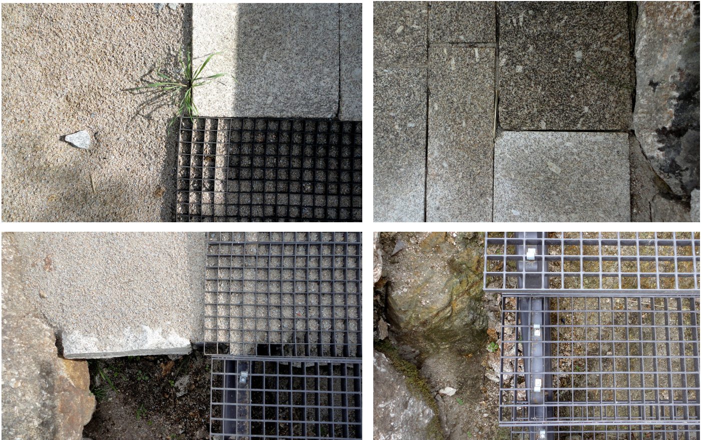
Fig.60: Pormenores dos materiais distintos (Fonte: João Almeida)
