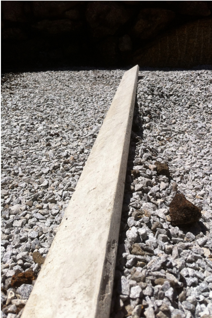
régua de obra-nivelamento de gravilha
