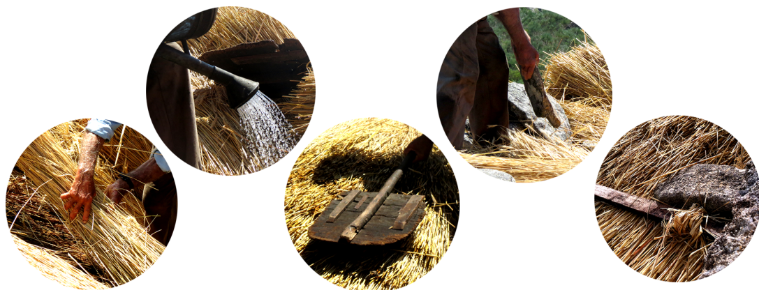
Fig.15: Esquema da colmagem- pormenores (Fonte: do autor)
