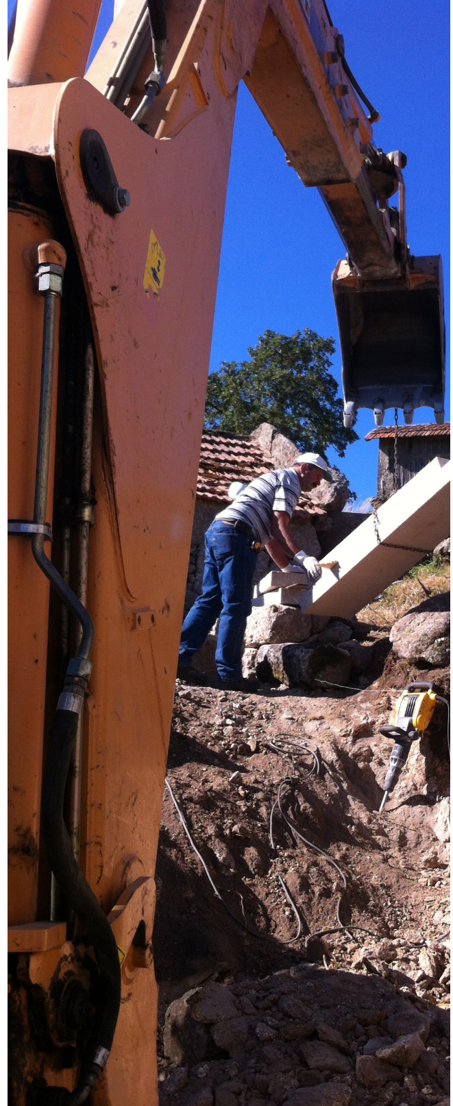
Fig. 78: Colocação das pedras no banco/muro (Fonte: do autor)
