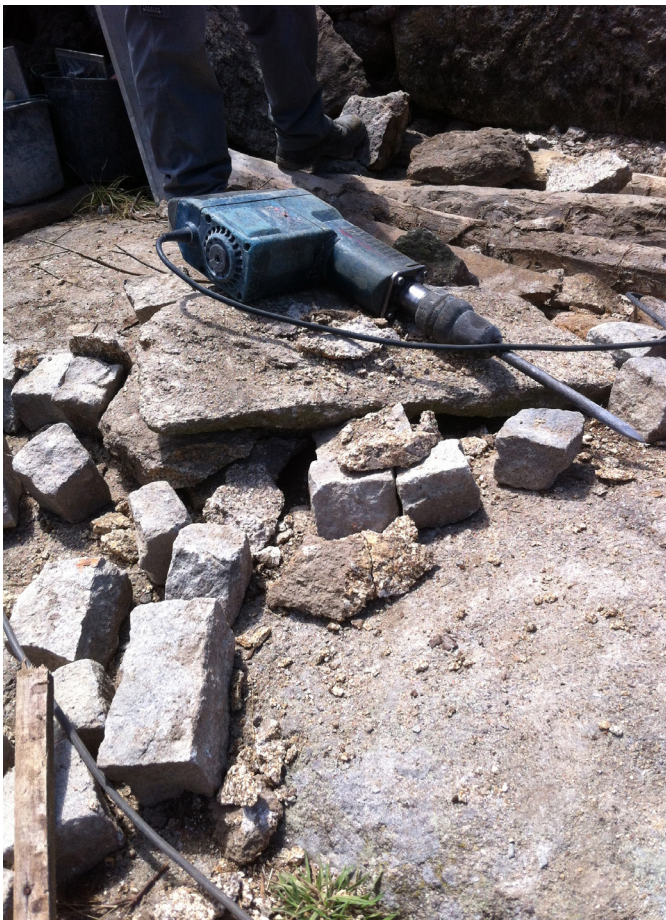
utensílio de pedreiro - martelo pneumático ou "motopico"
