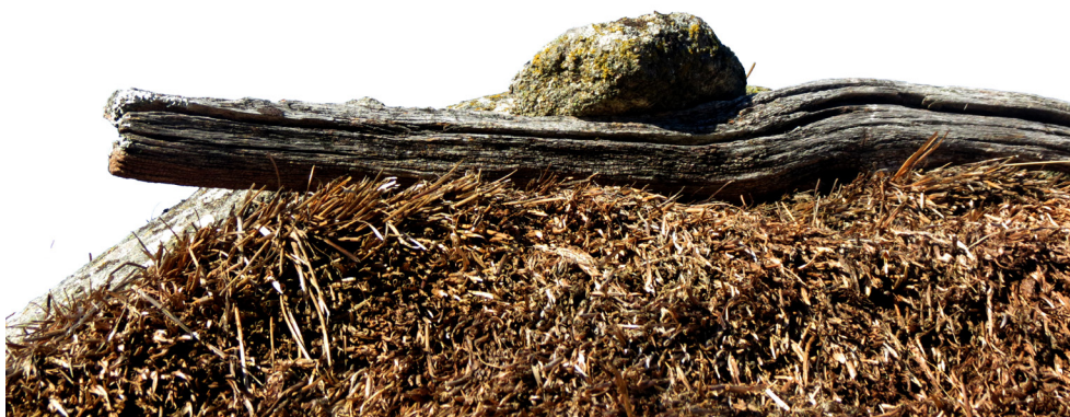
Fig.3: Pormenor cobertura em colmo (Fonte: do autor)
