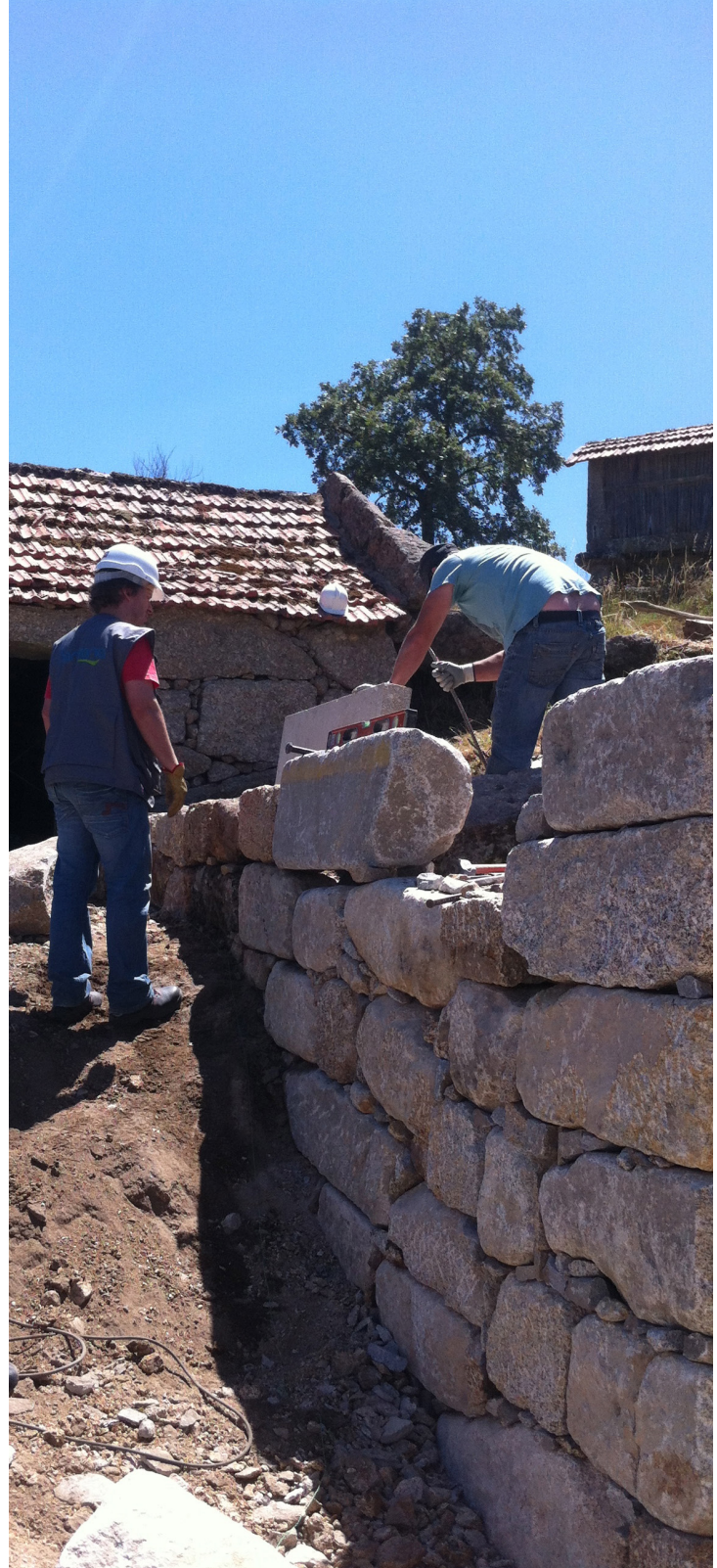
Fig.81: Execução do murete (Fonte: Cláudia Rodrigues)
