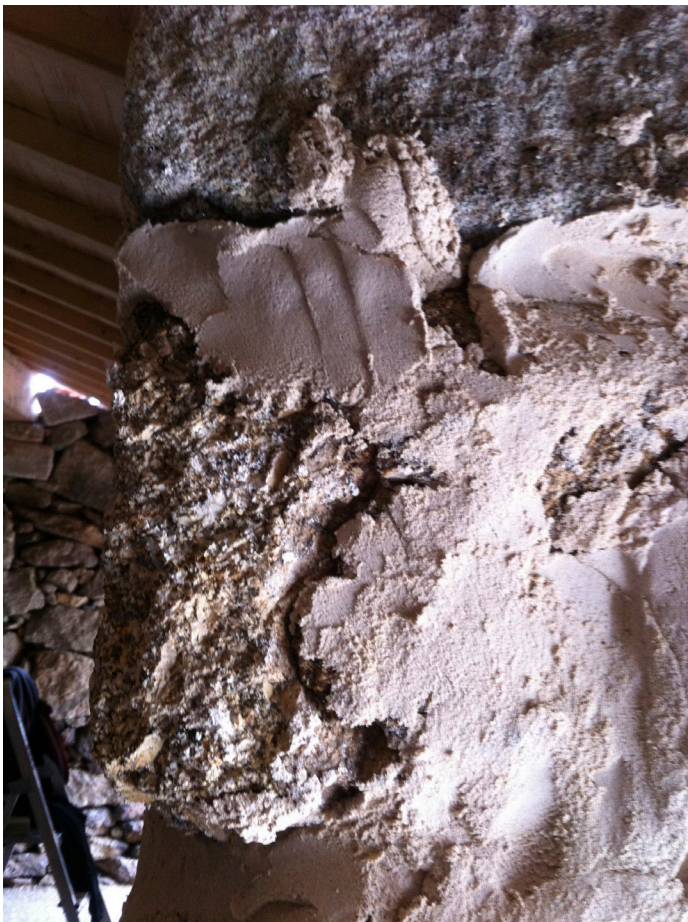
argamassa de juntas - colocação na parede
