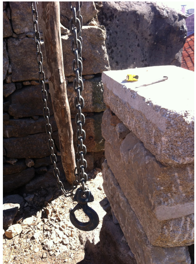
"garibalde" - levantamento de pedra - sistema tradicional
