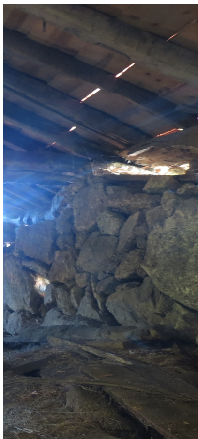
Fig.12: Edifício de Vale de Papas (Fonte:João Almeida)
