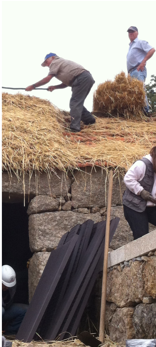
Fig. 75: Colocação do colmo na forja (Fonte: Cláudia Rodrigues)
