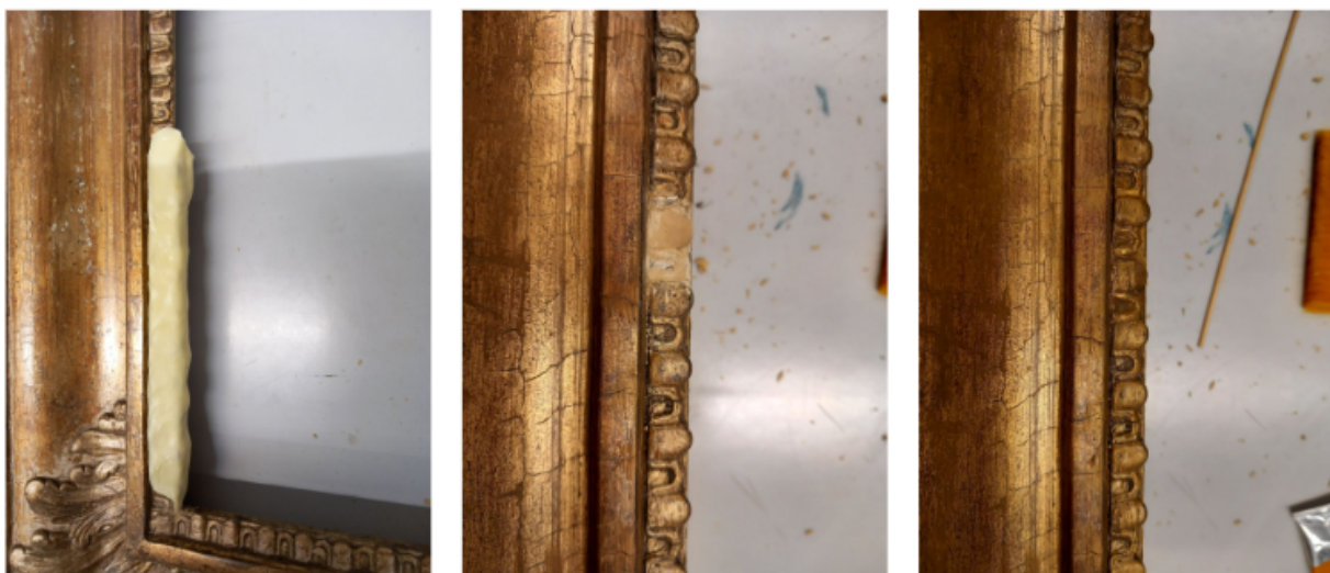
Figura 68: Detalhe da reconstrução volumétrica do friso decorativo - elaboração do molde, aplicação dos elementos volumétricos e reintegração cromática.
