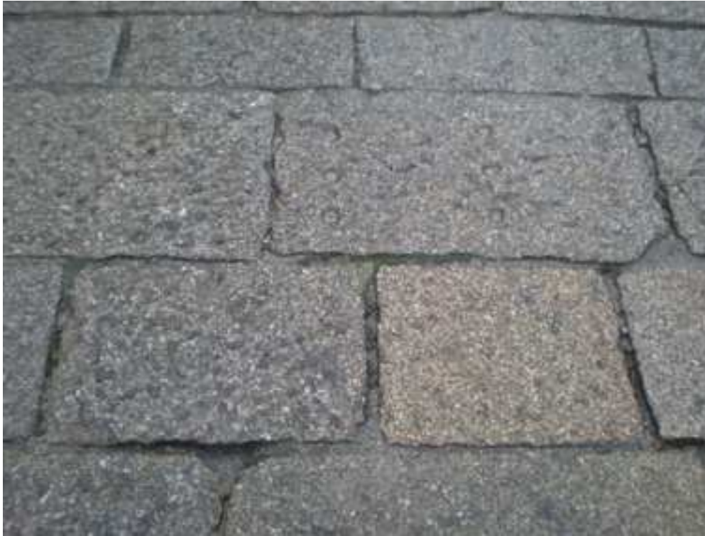
Figura 21 - Granito rachado (cubos e paralelos)
