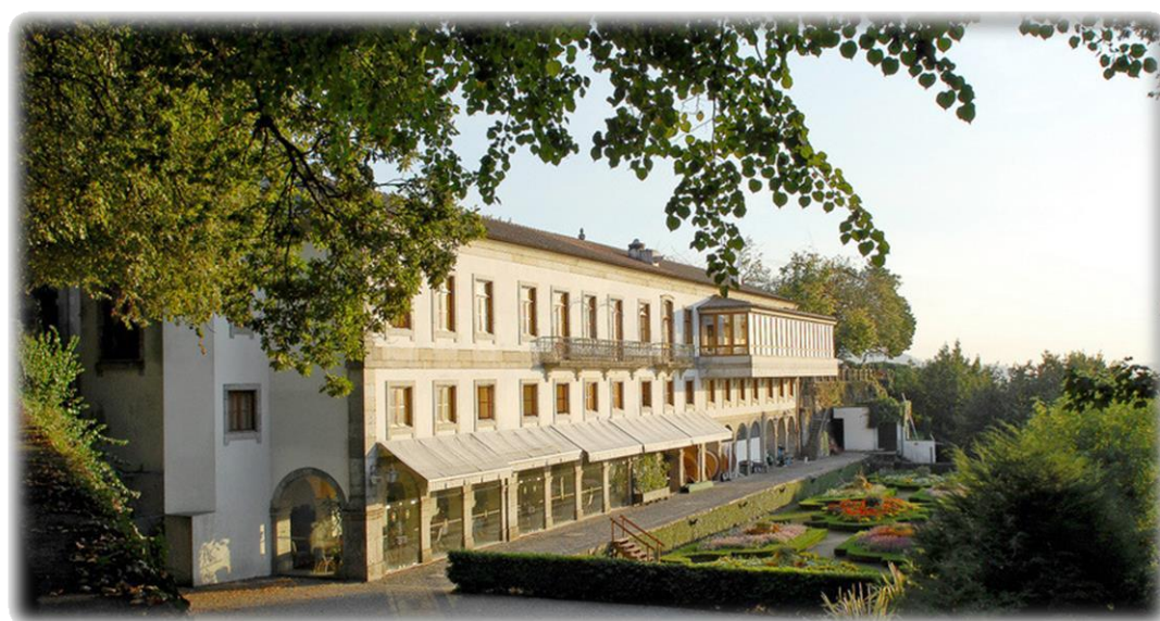
Figura 8 – Hotel do Elevador; Fonte: Website HBJ
