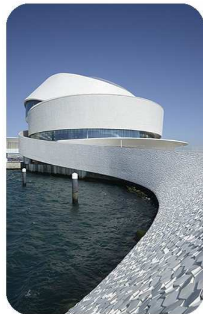
Figura 5 - Edifício do Terminal de Leixões. Fonte: APDL
