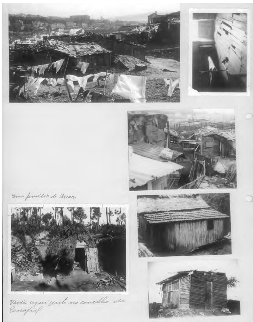
Casas do Património dos Pobres em Ovar e Penafiel.
