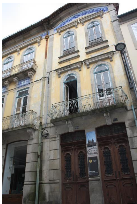
Imagem 15 – Fachada do acesso aos pisos 1, 2 e 3 devolutos, Rua do Comércio
