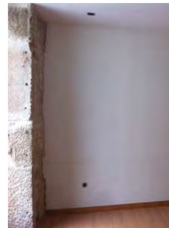
Parede interior existente em contacto com gesso cartonado | COMPARTIMENTO 3
