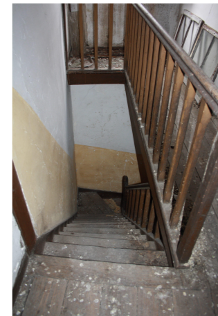
Acesso superior do piso 2 ao piso 3 | COMPARTIMENTO 36
