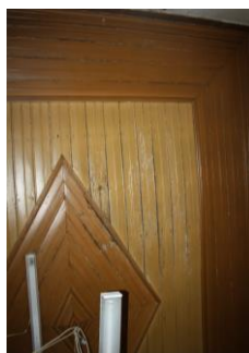
Imagem 28 – Revestimento do teto
