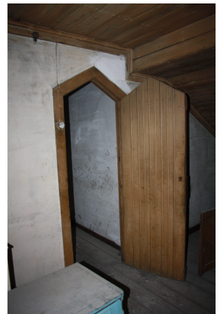
Vão interior existente | COMPARTIMENTO 39
