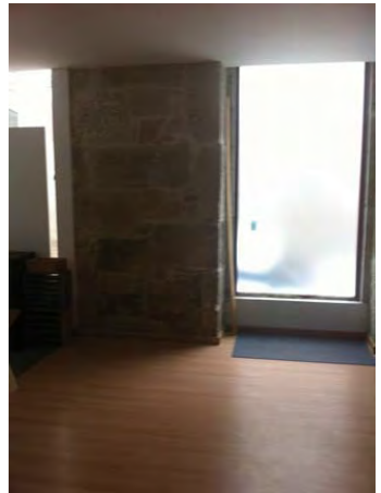
Parede da fachada em alvenaria de pedra | COMPARTIMENTO 3
