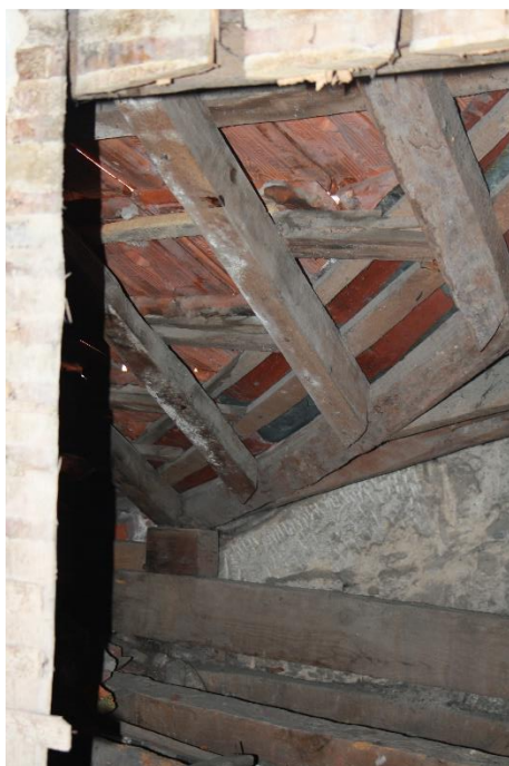
Imagem 48 – Estrutura da cobertura (visível) sem isolamento ou revestimento interior
