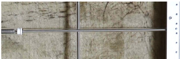
Figura 75 - Fixação na extremidade oposta ao tensor por uso de varão roscado
