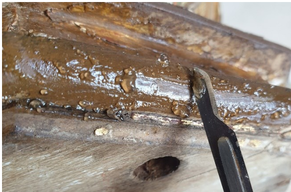
Fig. 859 - Remoção de substância filmogénica desconhecida com solução de solventes gelificada e bisturi.
