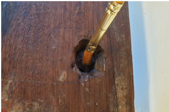
Fig. 806 - Aplicação de ácido tânico nos elementos metálicos de ligação (espigão de ferro).
