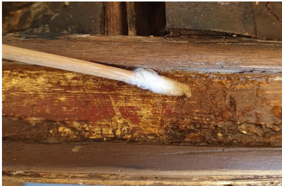
Fig. 861 - Remoção de substância filmogénica desconhecida com solução de solventes gelificada.
