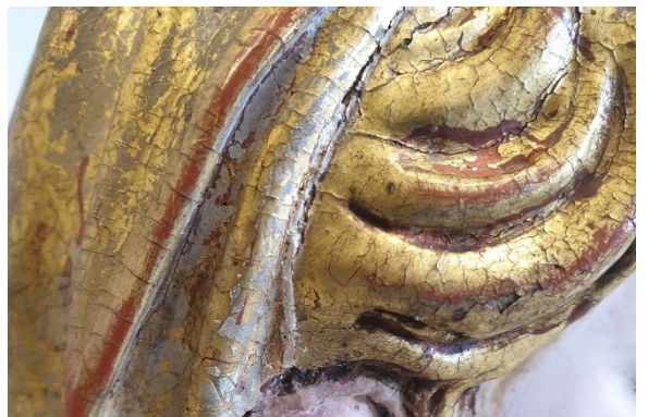
Fig. 827 - Pormenor após nivelamento preenchimento de fissura com madeira de balsa.
