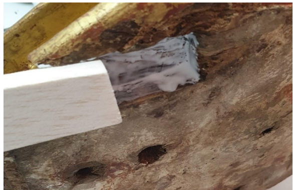
Fig. 821 - Colagem de elemento em madeira de balsa para preenchimento de lacuna do suporte.
