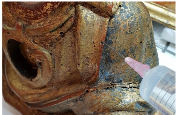
Fig. 803 - Consolidação por injeção com resina acrílica dissolvida num solvente orgânico aromático.
