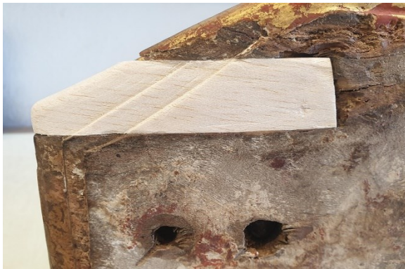
Fig. 824 - Pormenor de lacuna na peanha após preenchimento com madeira de balsa.
