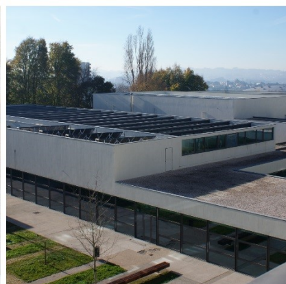
Fotografia 26 – Conjunto de painéis solares fotovoltaicos
