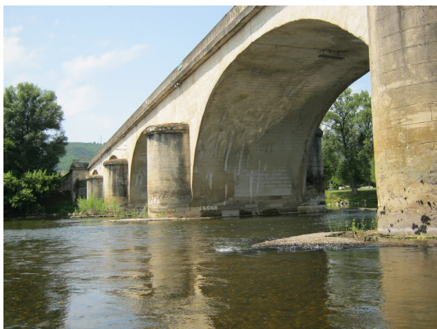
Fig. 2 Puente Louis - Vicat en Souillac, Francia.
