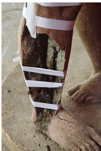
Fig. 66 Pérdida de sustrato de hormigón en el pie derecho de la figura masculina.
