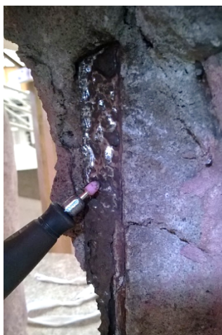
Fig. 82 Limpieza mecánica con herramienta eléctrica.
