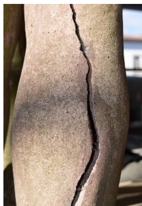
Fig. 62 Grieta en la pierna derecha de la figura masculina.
