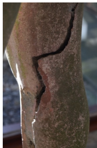
Fig. 69 Detalle de agrietamiento y levantamiento, pierna derecha de la figura femenina.
