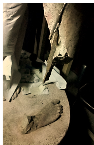
Fig. 90 Aspecto de la pierna derecha de la figura masculina después de eliminar el óxido y desprender el fragmento de pierna en peligro de colapso.
