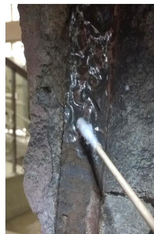
Fig. 83 Limpieza del polvo de óxido de hierro con etanol sin cetrimida 70%.
