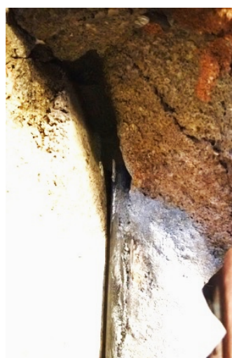
Fig. 97 Zona de acoplamiento de vara de fibra de carbono en el hormigón de la pierna derecha masculina.
