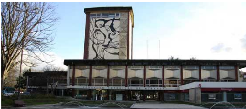
Fig. 51 - Fundação Cupertino de Miranda, Vila Nova de Famalicão
