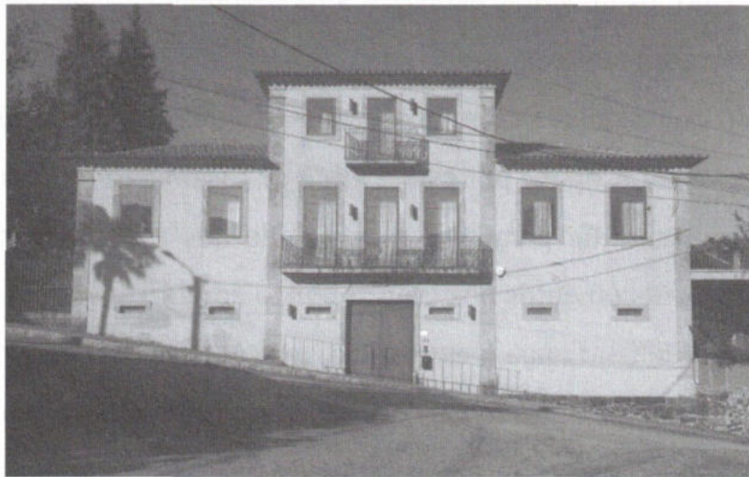
Fachada principal da moradia de António da Conceição Neves Cardoso em Mansores, edificada em 1863.
