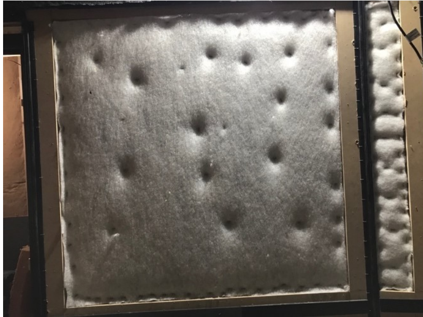
Figura 11 - Camada de espuma sob placa de Viroc
