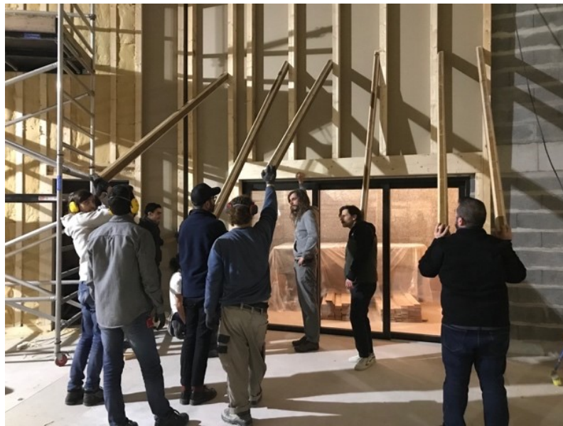
Figura 4 - Parede de madeira sendo fixada
