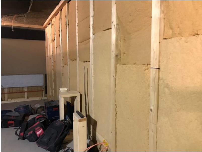
Figura 3 - Parede de madeira revestida de Gutex
