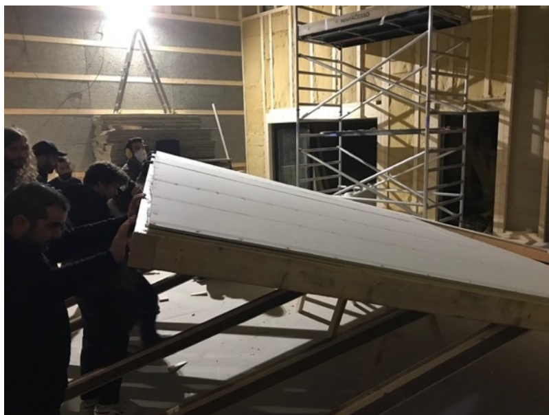
Figura 2 - Parede de madeira sendo erguida pela equipe
