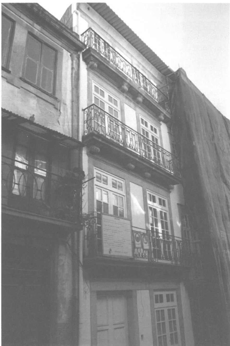
Fig. 6 - Fachada do prédio nº 9 a 11 da rua de S. Miguel, onde foi descoberto o presumível hekhal e que é actualmente a terceira casa a partir da igreja.
