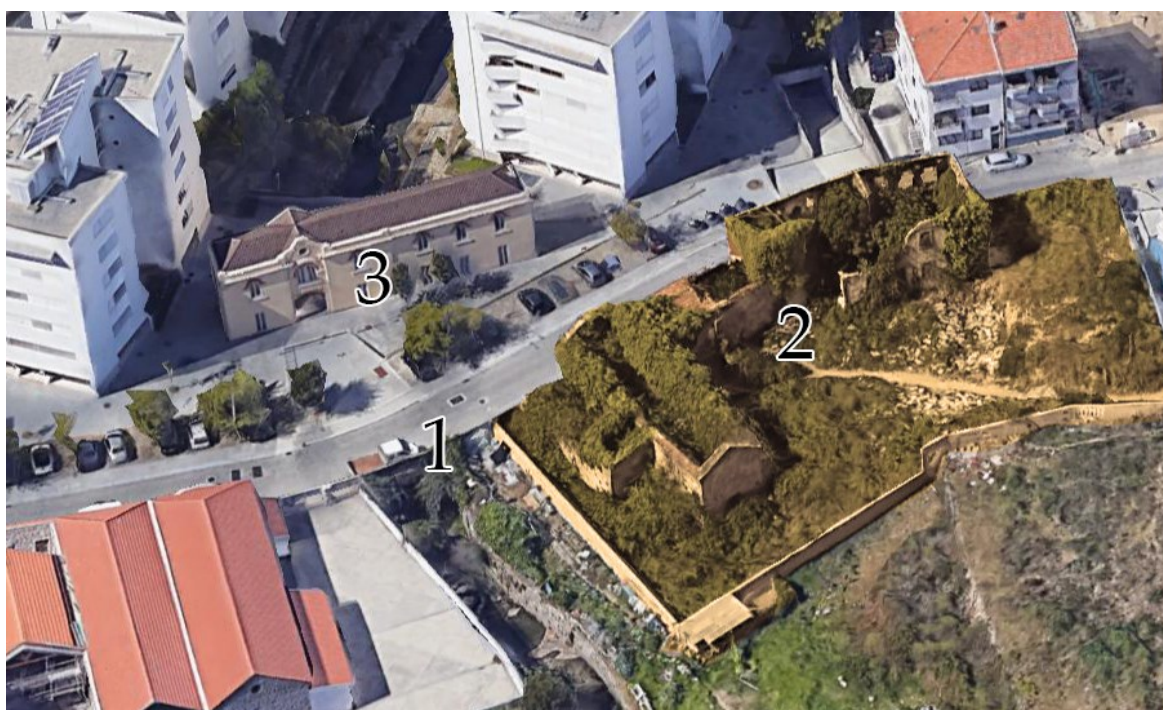
Fig. 55 - Perspetiva atual do Lugar da Ponte em Lordelo: 1 - Ponte; 2 - Ruínas de São Francisco de Paula; 3 - Antiga portaria e escritórios (1918-21) da Fábrica de Lanifícios de Lordelo (Google Earth; ©MBPastor).
