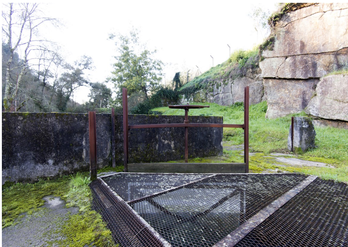
Fig. 95 - Comporta 3 e levada de alimentação da turbina de 1932 (©MBPastor).
