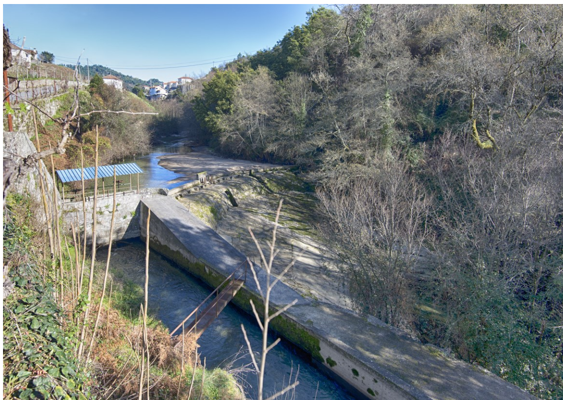
Fig. 93 - Comporta 1 e respetiva levada de desvio de água para os canais da fábrica (©MBPastor).
