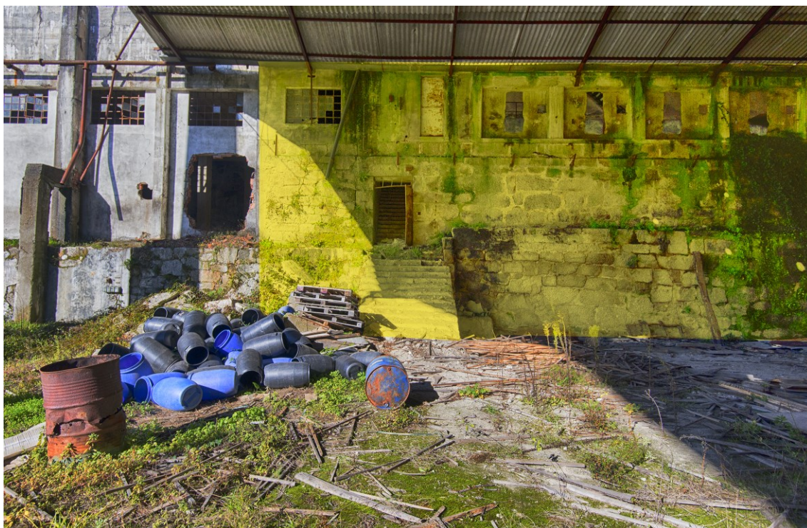
Fig. 87 - Remanescente atual da oficina de tecelagem manual (2a) (©MBPastor).
