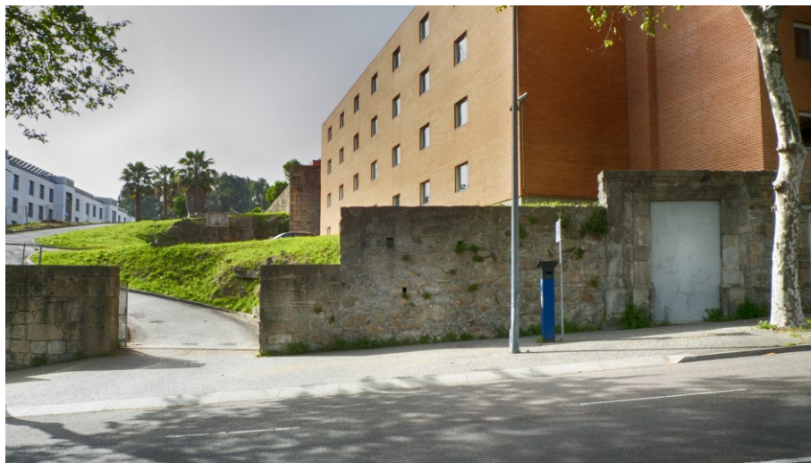
Fig. 44 - Vista atual do muro e portão da antiga Barbot & Meireles , Rua D. Pedro V, Porto (©MBPastor).
