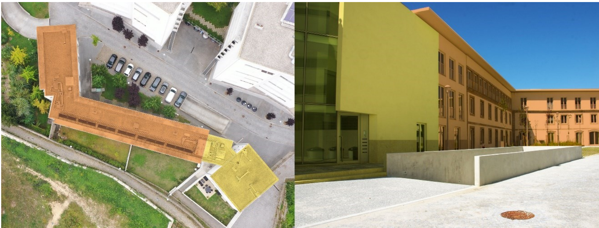
Fig. 72 Elementos reconstruídos do fragmento do edifício do século XIX: a laranja reconversão da ruína e amarelo acrescento do grupo SACHE (esquerda:.. voo de drone 2020; direita: vista atual do pátio ©MBPastor).
