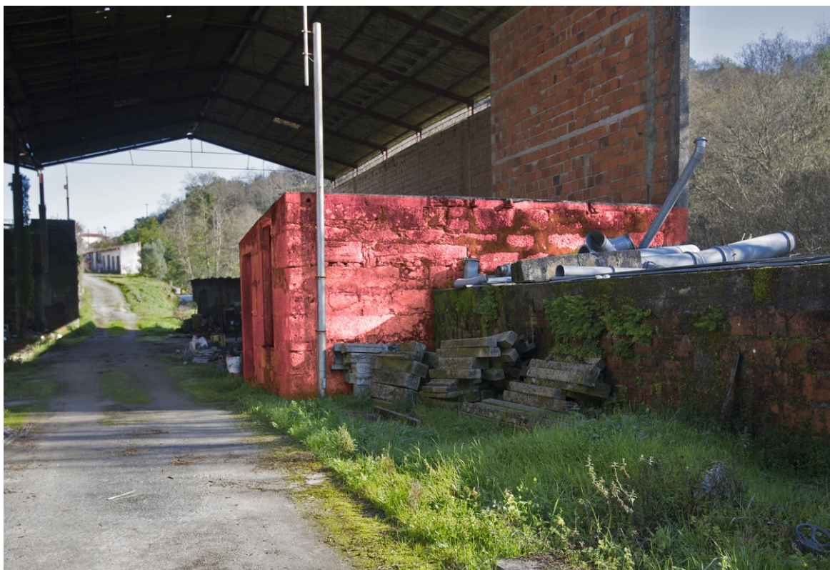
Fig. 79 - Vista atual de parte da estrutura onde esteve instalada a roda hidráulica, destaque a vermelho (©MBPastor).
