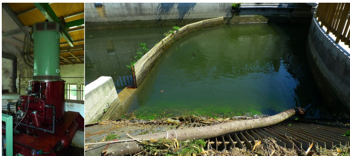
Fig. 26 - Novo alternador, para geração elétrica, tanque de abastecimento e grade de filtragem da turbina original da Costas & Carvalho (©MBPastor).
