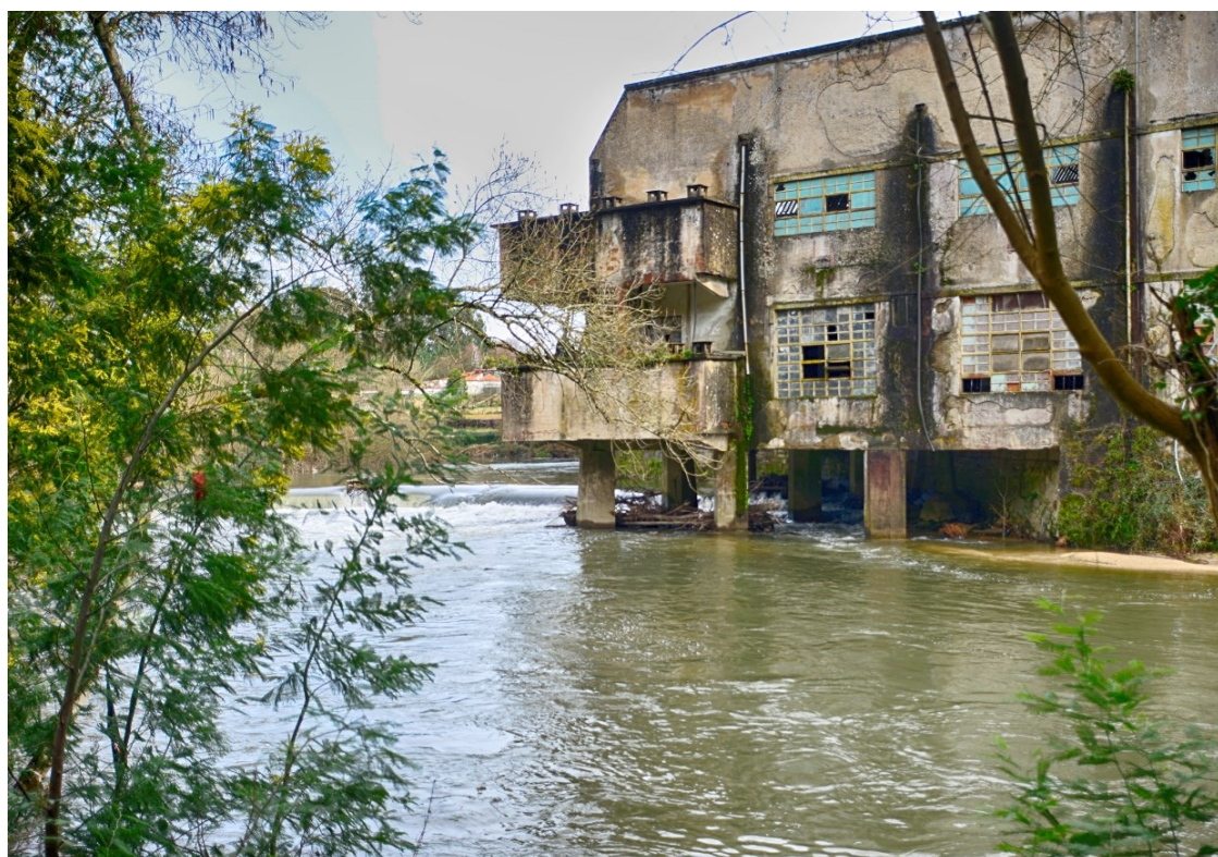
Fig. 113 - Vista dos varandões da Sampaio, Ferreira & Cia. Lda. sobre a antiga levada de Pena Cabrão . A fiação (e residência) original de Narciso Ferreira, identificada em 1896 no documento de escritura da empresa estava instalada nesta área, hoje prolongada com os pavilhões sobrepostos sobre o Ave (©MBPastor).
