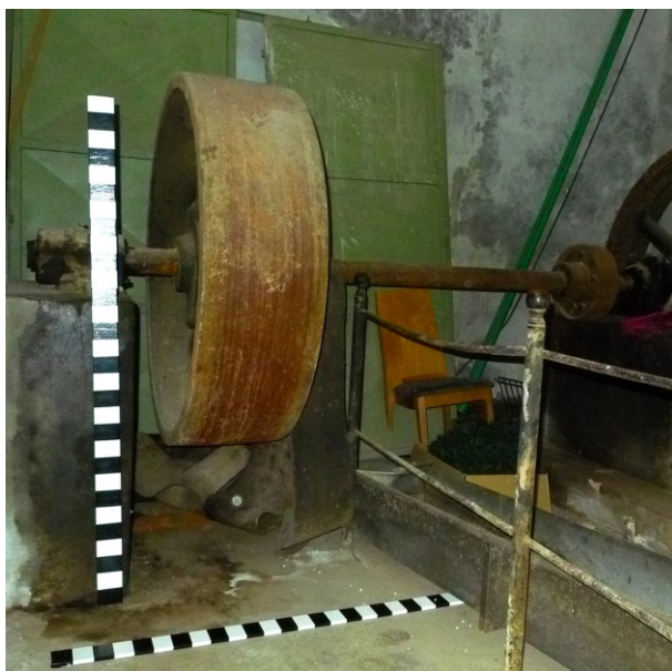
Fig. 30 - Veio de transmissão da turbina com respetiva roldana de distribuição (©MBPastor).
