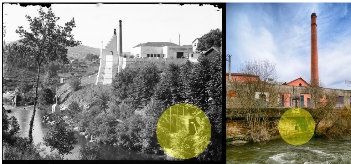
Fig. 107 - Fotografia de Alvão (cerca de 1934-1950) à esquerda (CPF) e vista atual da antiga fábrica do barão da Trovisqueira, com a saída de água da roda e respetiva comporta assinalados (©MBPastor).
