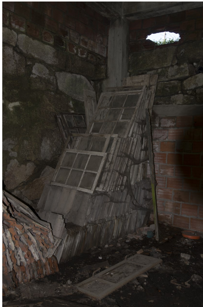
Fig. 89 - Depósito de caixilhos de janela e telhas do edifício original (©MBPastor).
