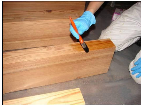
Fig.92 – Pormenor da aplicação de resina epóxida nos barrotes de pinho de riga, posteriormente colocados na base da obra.
