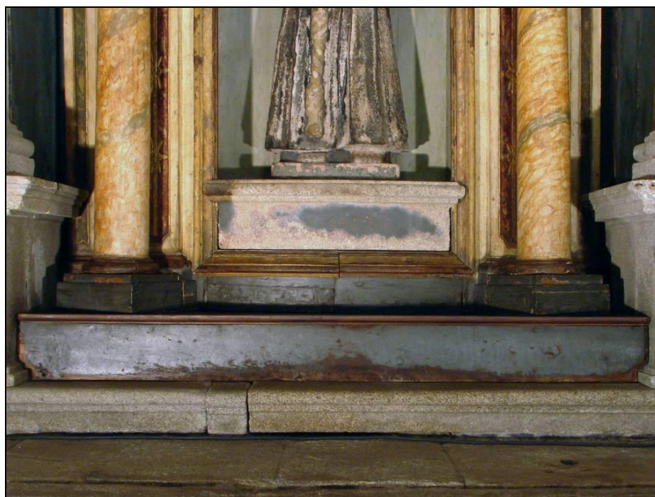
Fig.117 – Vista geral da base do nicho.
