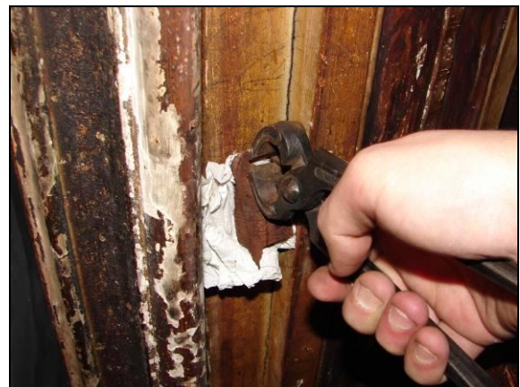
Fig.74 – Pormenor da remoção de um prego oxidado que já não exercia a sua função, com auxílio de uma torquês.
