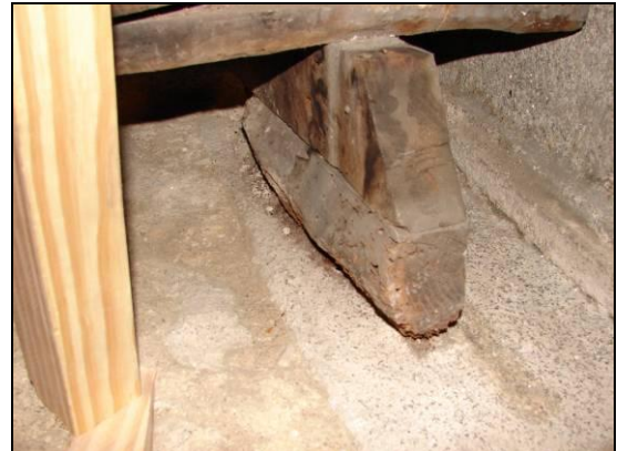
Fig.70 – Pormenor do barrote de suporte da estrutura, no lado direito, segundo o ponto de vista do observador.
