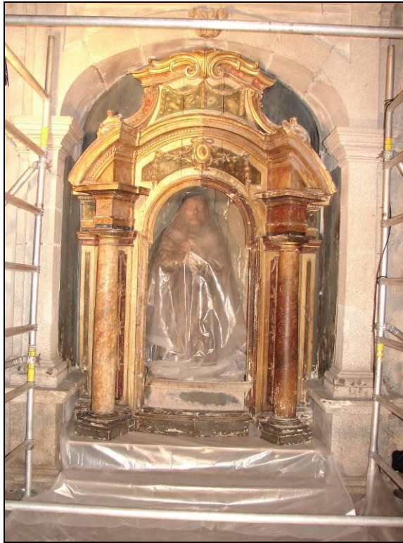
Fig.85 – Vista geral da obra após a limpeza química da metade esquerda.
