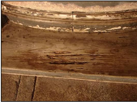
Fig.51 - Pormenor do elemento lenhoso colocado em volta da moldura do arco do nicho.
