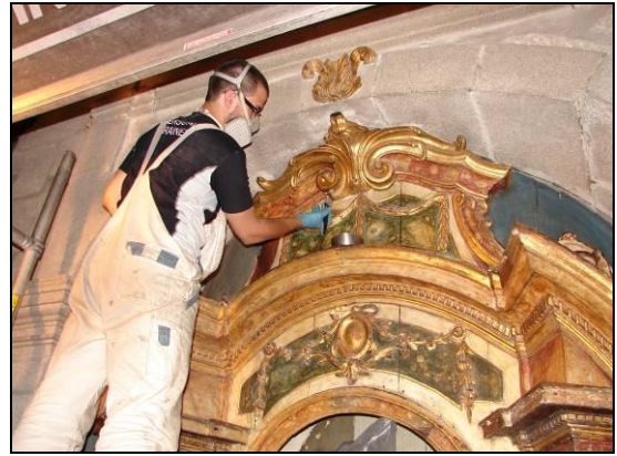
Fig.114 – Pormenor da aplicação da proteção final (Paraloid B72 em tolueno na concentração de 3%) na obra.
