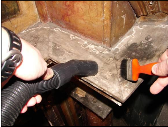
Fig.71 – Pormenor da limpeza de poeiras e sujidade depositadas na superfície da obra.
