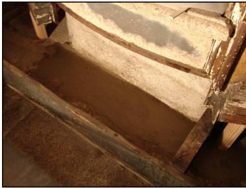
Fig.91 – Chão de pedra por baixo da base, após o preenchimento com argamassa das fendas entre as pedras.
