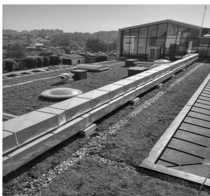
Centro de Atendimento Municipal (CAM) da Póvoa de Varzim
