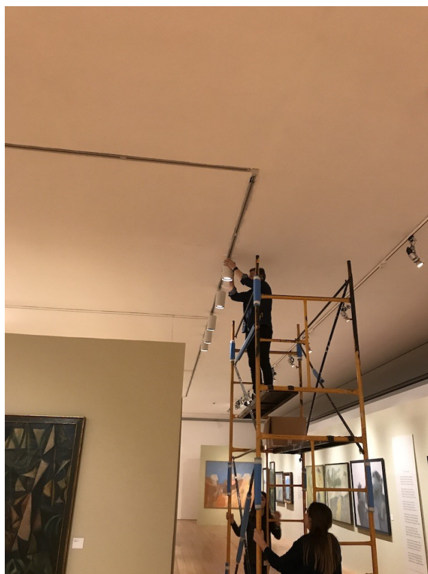
Figura 32- Colocação de projetores e orientação da iluminação
