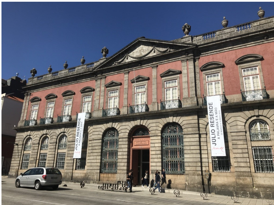
Figura 36- Colocação de publicidade na entrada do edifício
