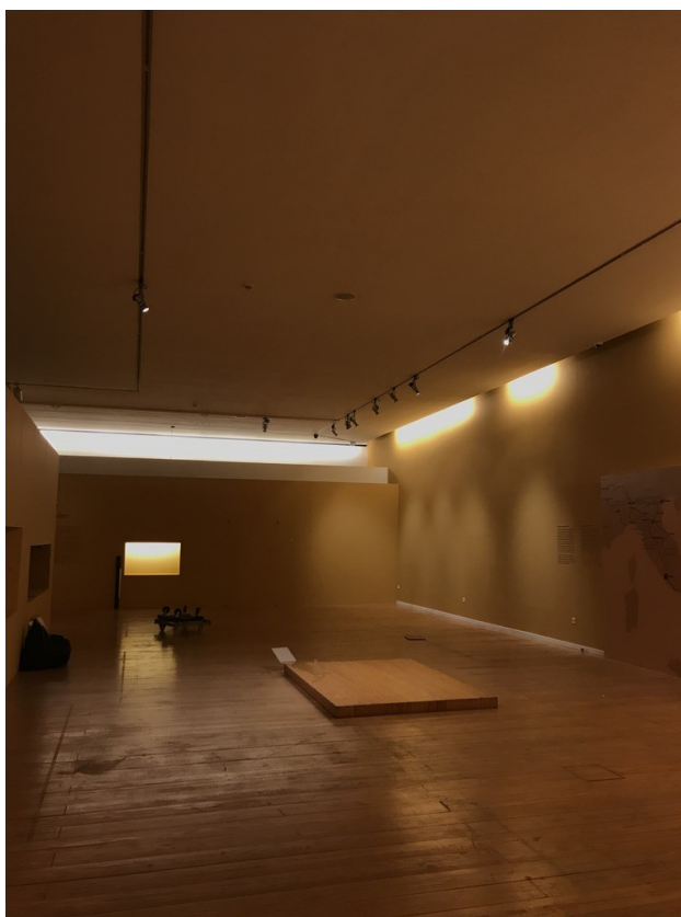
Figura 4- Obras e preparação da sala de exposições
