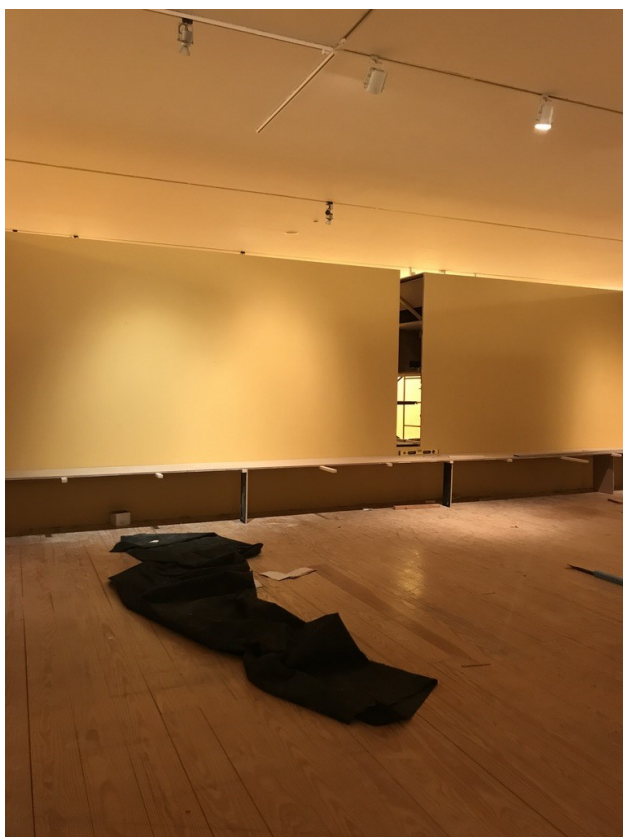
Figura 6- Obras e preparação da sala de exposições
