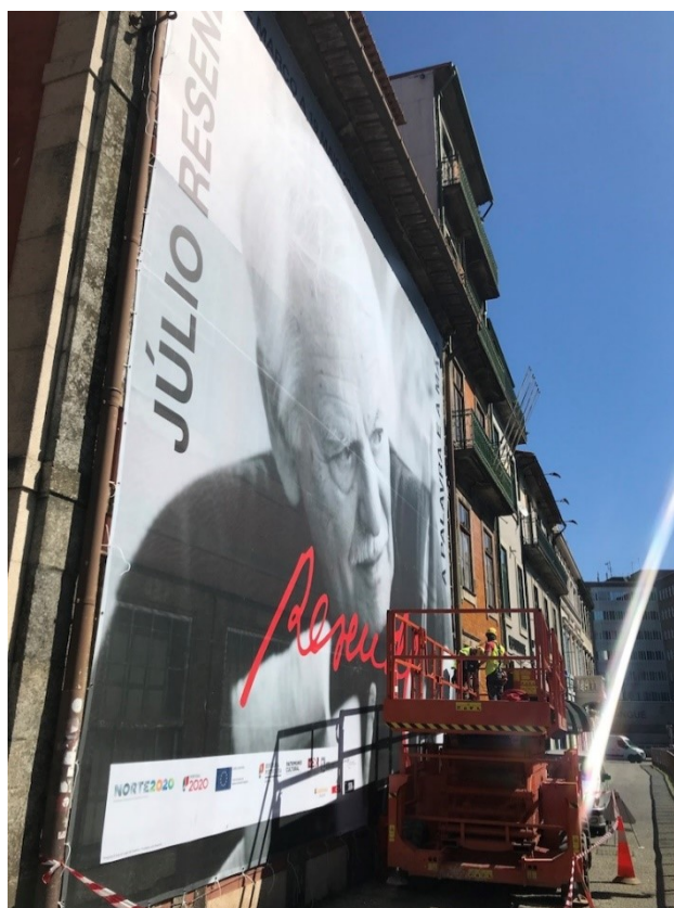
Figura 34- Colocação da lona na fachada do edifício dos serviços do museu
