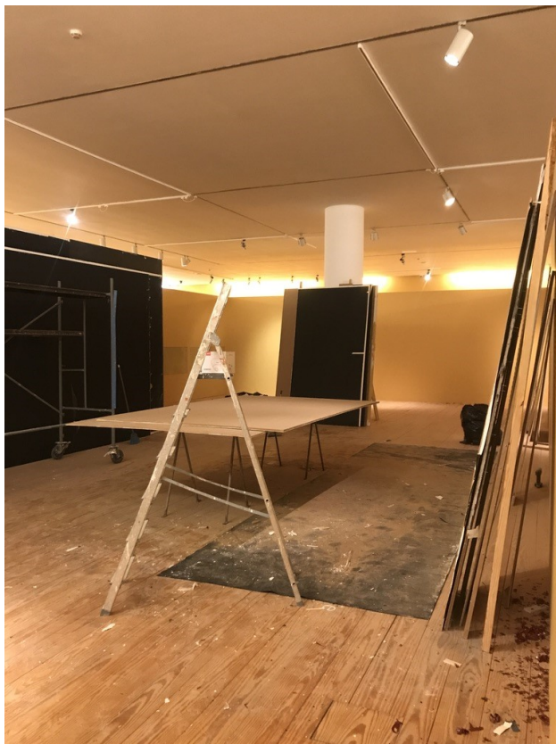
Figura 5- Obras e preparação da sala de exposições
