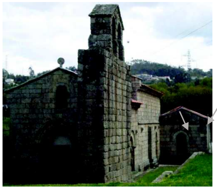
Figura 110. Fachada principal (oriental) com alterações pontuais nos elementos arquitectónicos salientes e na lateral do campanário. ©2013, A Autora
