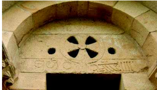
Figura 18. Inscrição no tímpano do portal lateral Sul. ©2015, Frederico Henriques
