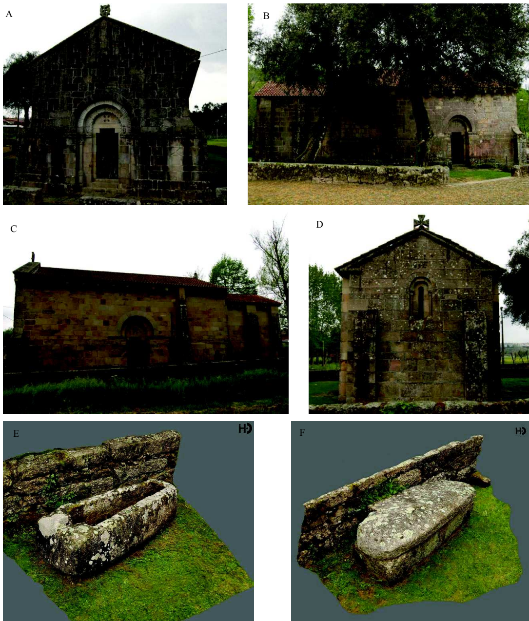
Figura 87. (A) Pórtico principal, fachada Oeste. (B) Fachada lateral Sul. (C) Fachada lateral Norte. (D) Cabeceira (Capela-mor), fachada Este. (E) Sepultura escavada no granito sem tampa. (F) Sepultura escavada no granito com tampa. ©2015, Frederico Henriques
