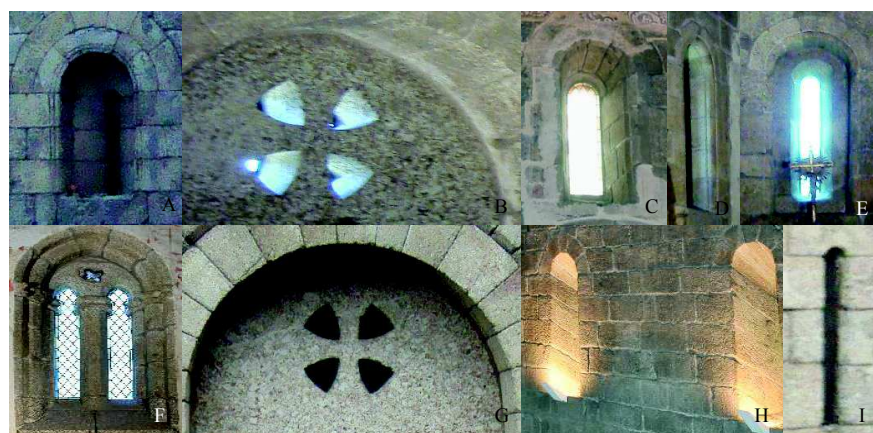
Figura 121. Aberturas para entrada de luz na Igreja de Santa Cristina: (A) Fresta no portal axial (O.); (B) Cruz em x vazada encimando o pórtico lateral esquerdo da fachada N.; (C) Fresta sobre o arco triunfal da nave; (D) Fresta da capela-mor na fachada N.; (E) Fresta na parede fundeira da capela-mor (Este); (F) Fresta na parede fundeira da sacristia (Este); (G) Cruz em x vazada encimando o pórtico lateral direito da fachada S.; (H) Frestas da nave na fachada S.; (I) Fresta do nártex na fachada S. ©2013, Eduarda Vieira e Frederico Henriques
