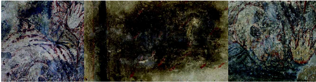
Figura 109. Eflorescências de sais sobre biofilmes negros, no painel mural do lado do Evangelho. ©2015, Frederico Henriques
