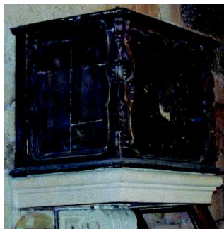
Figura 99. Púlpito em madeira com inúmeras fracturas, algumas lacunas de material como as do ornamento central, e desvanecimento da policromia. Os ornamentos salientes denotam desgaste e acumulação de pó generalizado. © 2013, Frederico Henriques
