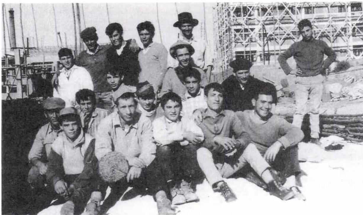
Membros do Instituto Regnum Dei no meio dos seus colegas de trabalho na construção civil, em Setúbal, em 1966 (in SOUSA – Presença , p. 164).
