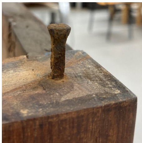
Fig. 48 – Aspeto de um dos elementos metálicos que fixavam o tampo, com oxidação evidente (fotografia do autor).
