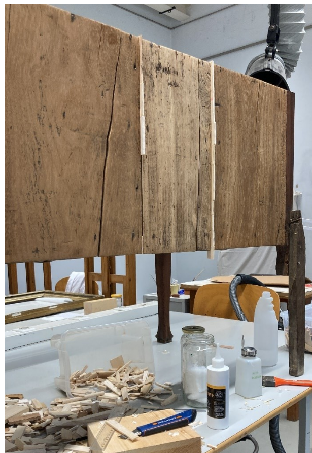
Fig. 51 – Processo de reintegração volumétrica das fissuras das tábuas do tardo do móvel, recorrendo à inserção e fixação (com PVA de pH neutro) de madeira de balsa (fotografia do autor).
