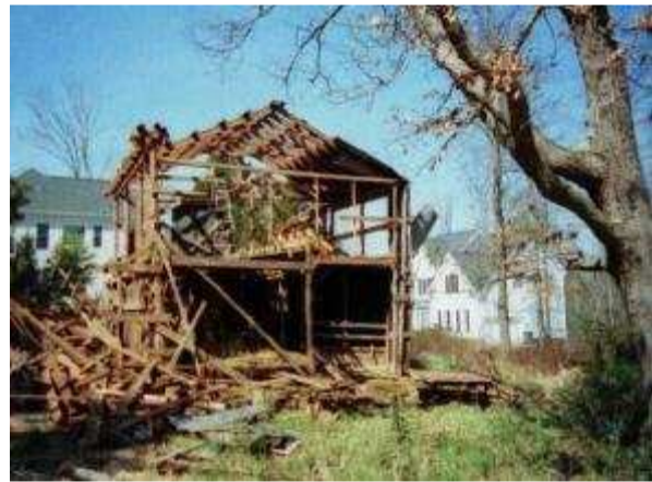
Figura 30: Demolição selectiva de um edifício.
