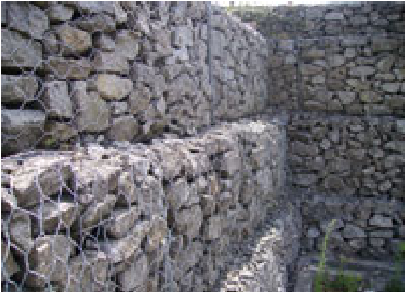
Figura 26: Muros executados com material britado “Muros Gabião”
