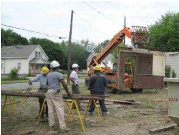
Figura 29: Demolição selectiva de um edifício.
