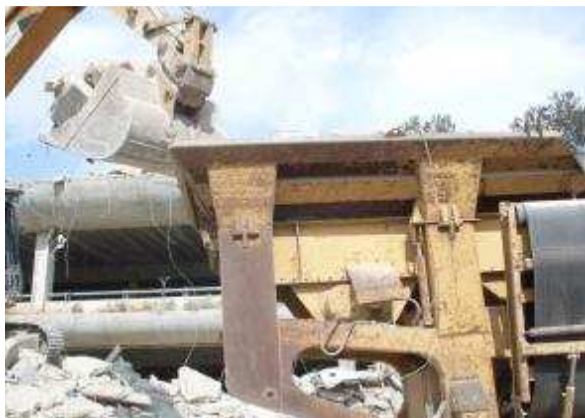
Figura 24: Britadeira em obra
