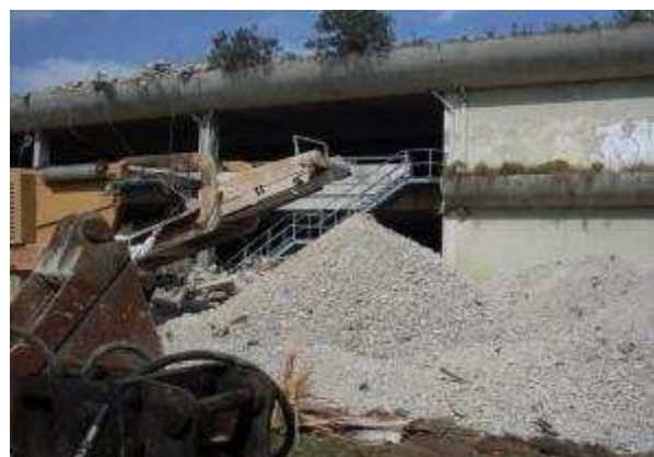
Figura 25: Material britado em obra
