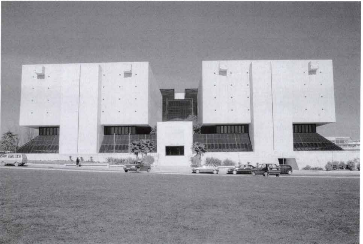
Edifício do Arquivo Nacional da Torre do Tombo, Lisboa.
