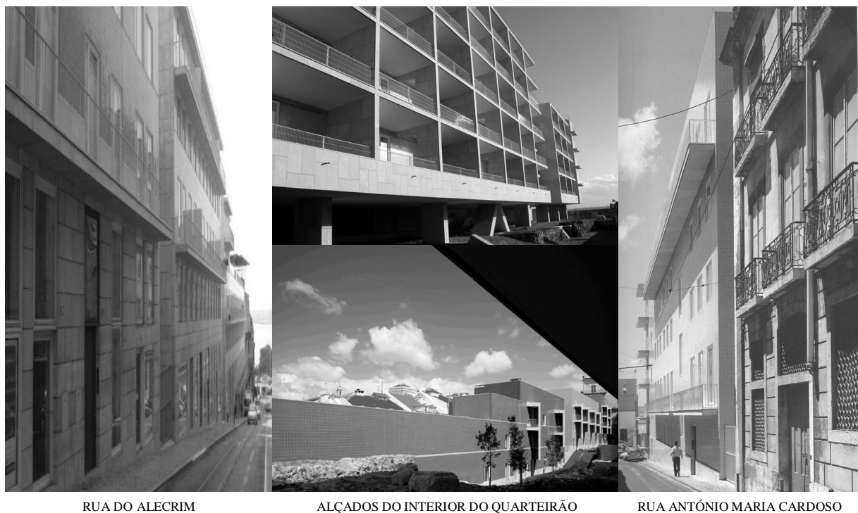
Fig. 6 - Fachadas do edifício Terraços de Bragança
